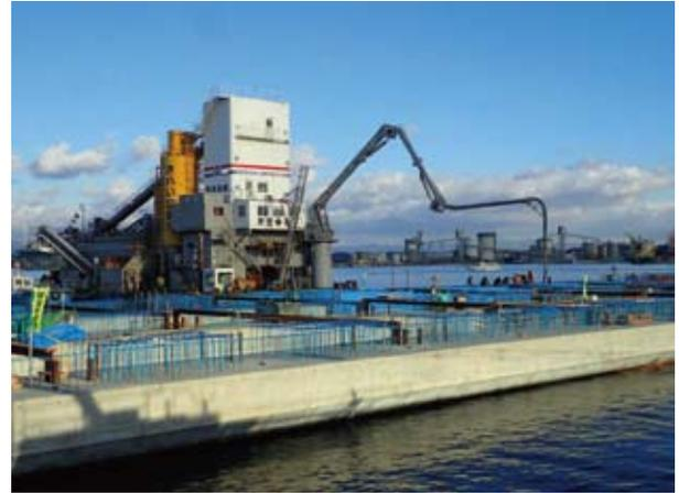
写真-2 岸壁(-18m)(耐震)横受梁コンクリート打設状況
