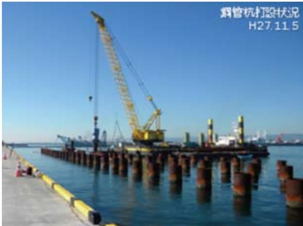
写真-1 岸壁(-18m)(耐震)鋼管杭打込状況
