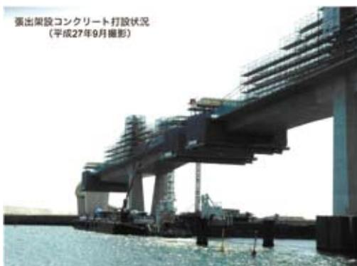
写真-4 航路部上部中央径間整備状況
