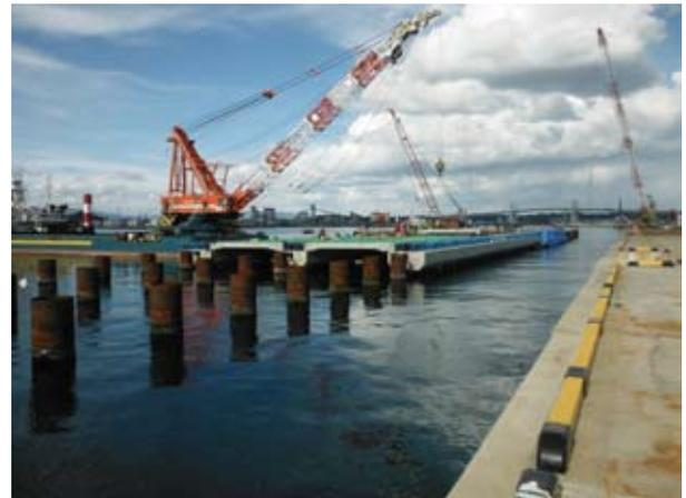
写真-3 岸壁(-18m)(耐震)PCホロー桁設置設状況
