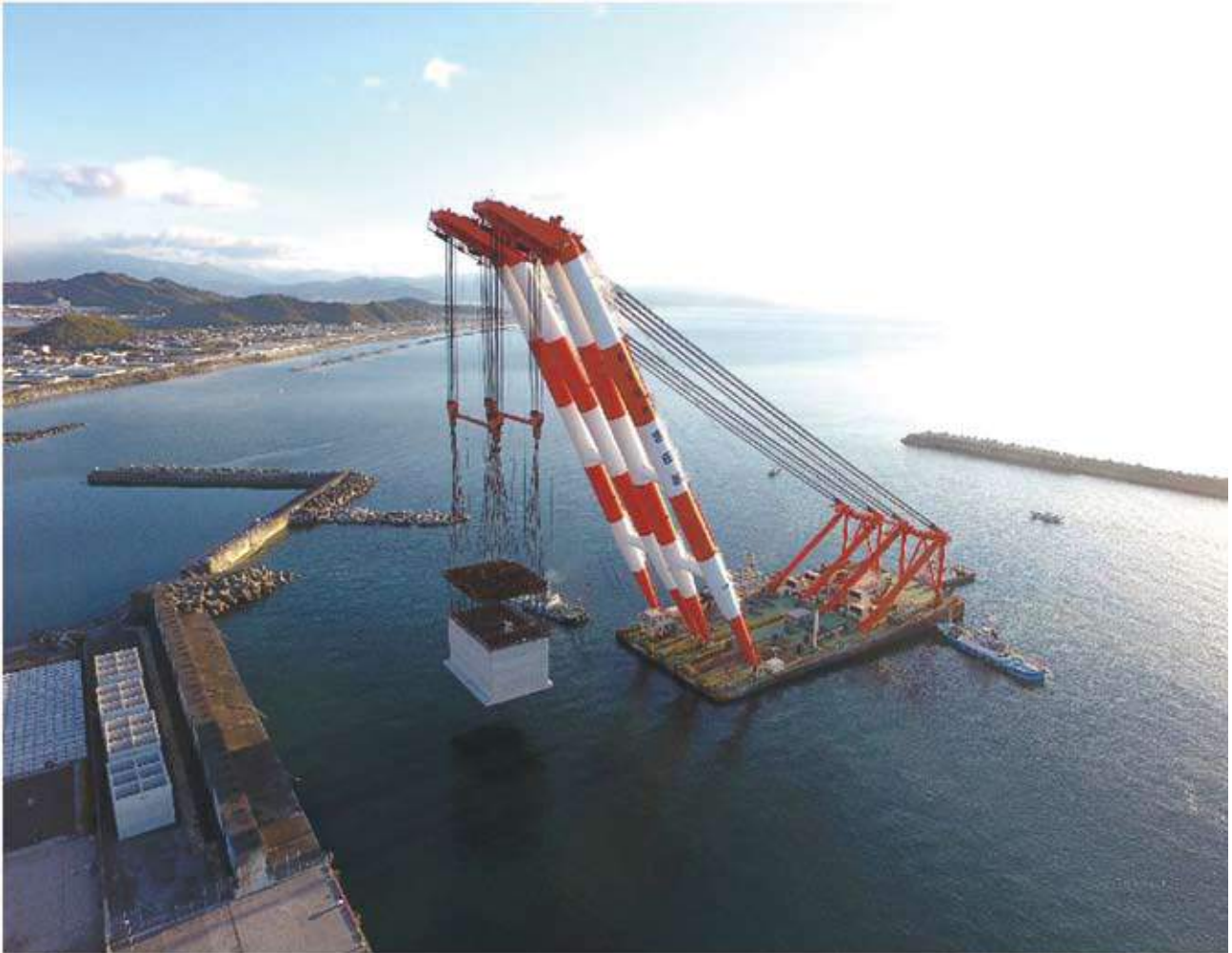
ケーソンの据付状況
