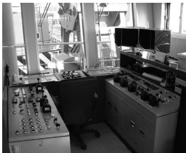
写真-5 集中操作盤
