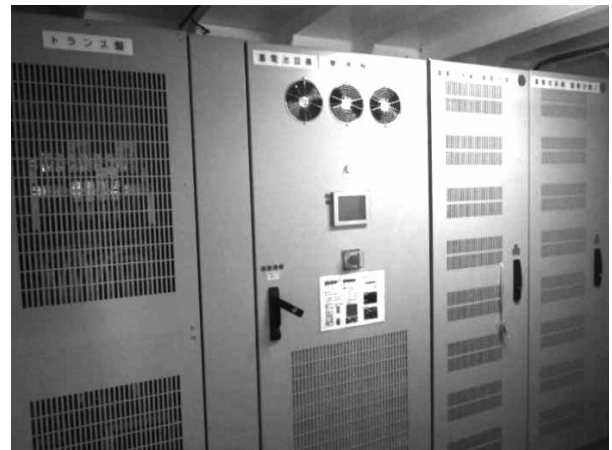
蓄電池システム ユニット
