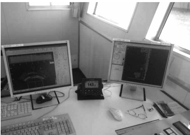
操作室 施工管理システム及びソナー
