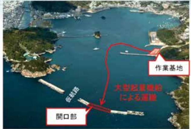
本体ブロック製作場所・据付場所
