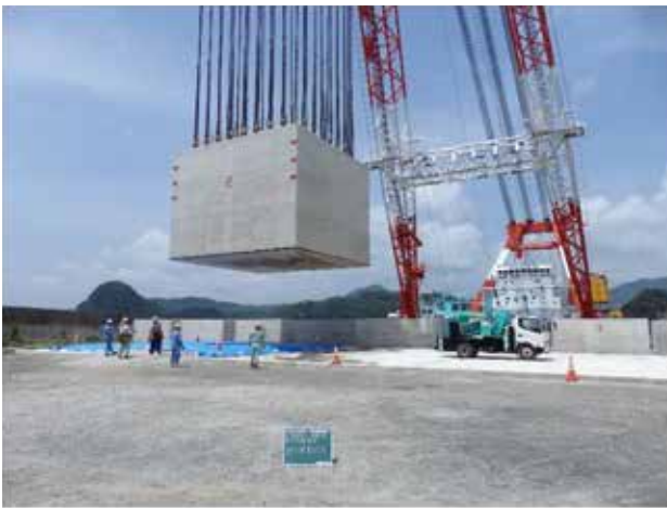
大型起重機船による本体ブロック吊上・海上運搬状況
