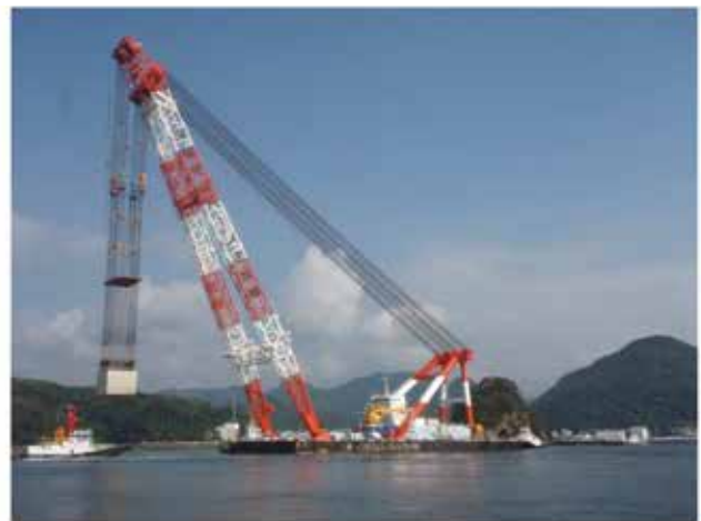
大型起重機船による本体ブロック吊上・海上運搬状況
