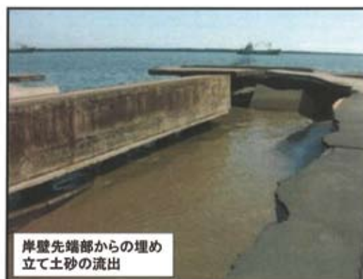
写真2 岸壁の被災例(茨城港日立港区)
