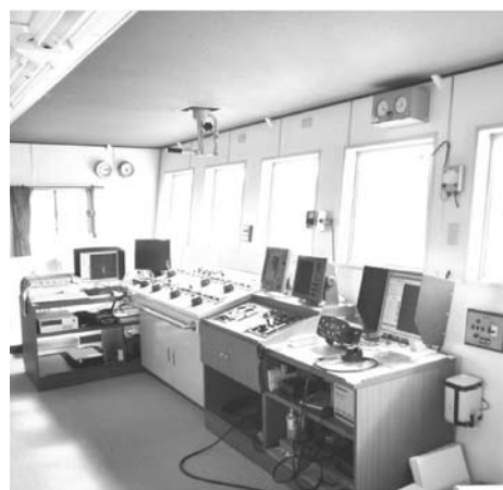
コントロール室の様子
