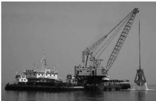
柏崎港 維持浚渫工事
