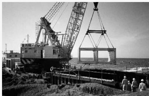
柏崎 農業排水路放水口据付工事
