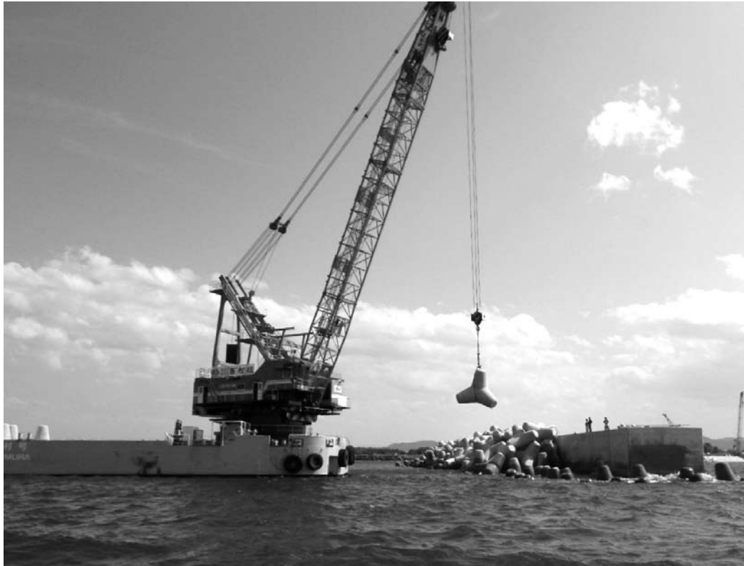
消波ブロック(25t)据付状況
