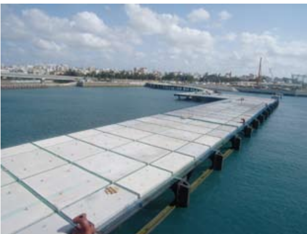
⑨コンクリート床版据付完了(H21施工箇所)
