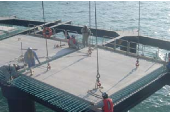
⑧コンクリート床版据付状況(H21施工箇所)
