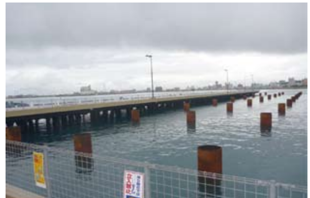
⑤鋼管杭打設完了状況
