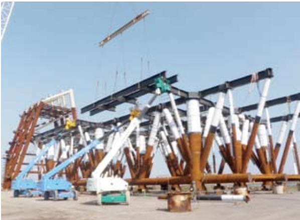
①ジャケット製作状況(北九州工場)
