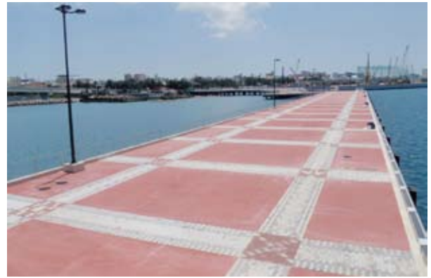
⑪舗装及びブロック設置完了(H21施工箇所)
