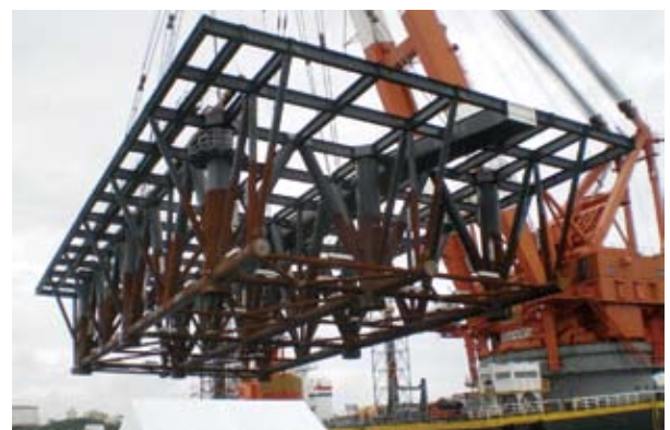
⑥据付状況
