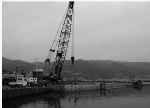
網代港 耐震岸壁工事 ケーソン据付工
