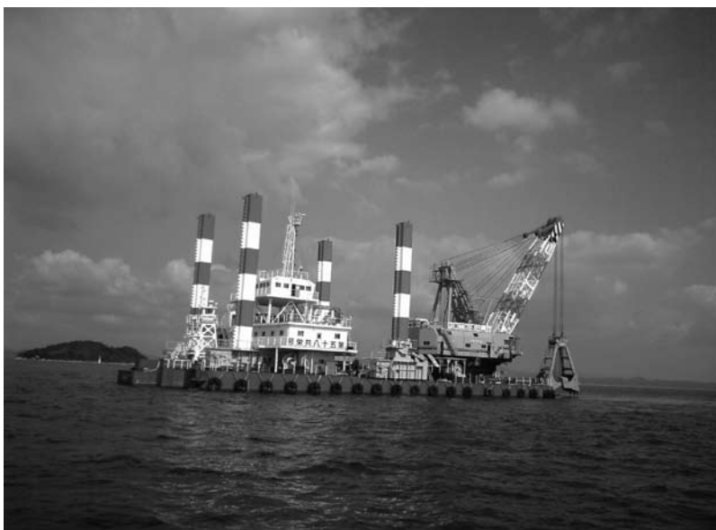
第58共栄号浚渫状況(関門航路)
