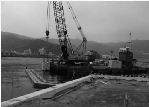
網代港 耐震岸壁工事 ブロック据付工
