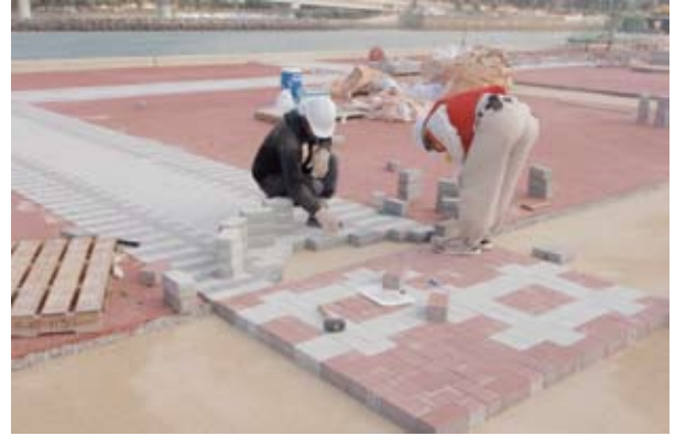
⑩舗装及びブロック設置状況(H21施工箇所)
