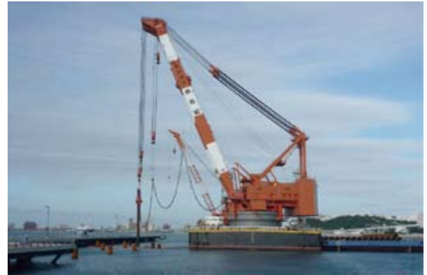
④鋼管杭打設状況
