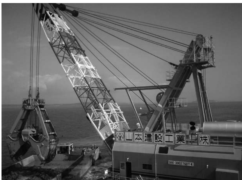
第58共栄号浚渫状況(関門航路)
