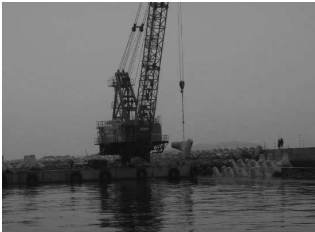
異形消波ブロック(10t)据付状況
