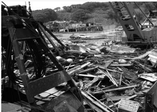
女川港の啓開作業
