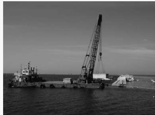
秋田港の港湾工事
