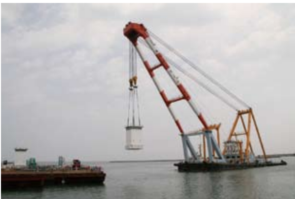
②主塔下部 基部ブロック架設状況
