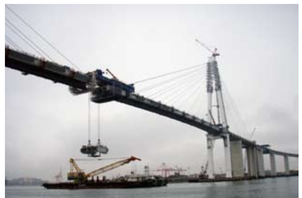
⑥中央径間 閉合ブロック架設状況
