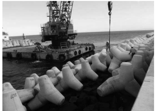
異形消波ブロック(10t)据付状況
