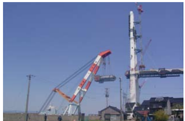
⑤中央径間 第1・2ブロック架設状況
