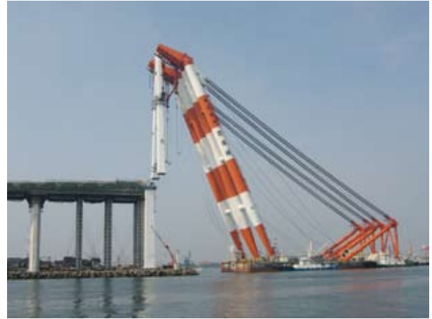
④主塔上部 大ブロック架設状況
