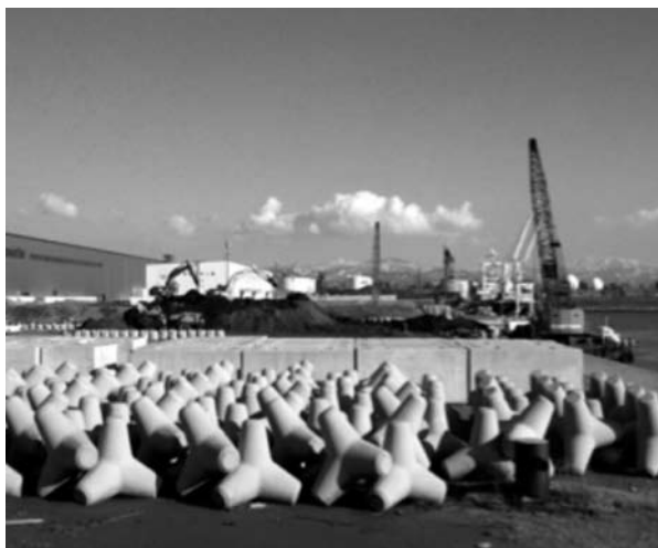
金沢港整備工事
