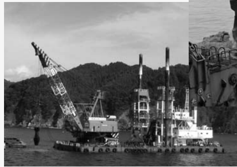
岩手県 釜石港ケーソン撤去(讃岐号)
