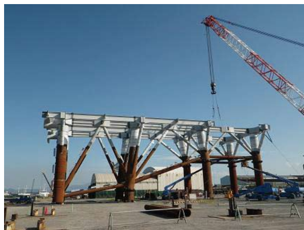
ジャケット工場製作状況(立体組立)
