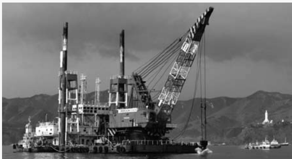
岩手県 釜石港ケーソン撤去(讃岐号)
