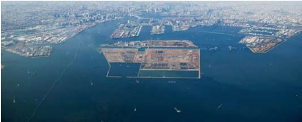
東京港 中央防波堤地区全景
