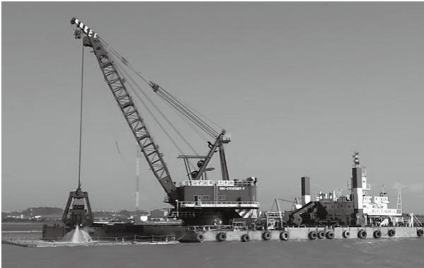
浚渫作業(第88協栄丸)
