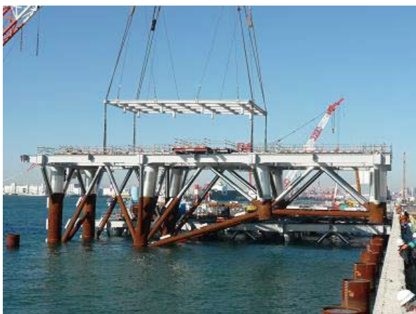
ジャケット据付状況
