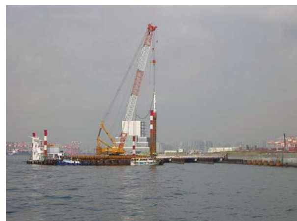
先行杭打設状況「第15吉野号」
