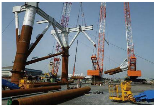
ジャケット工場製作状況(立体組立)
