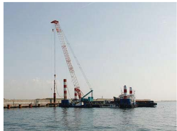
先行杭打設状況「第三十八御在所号」
