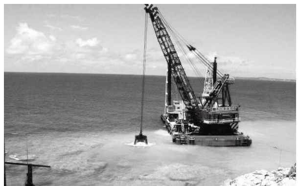
破碎岩浚渫作業(第七協栄丸)
