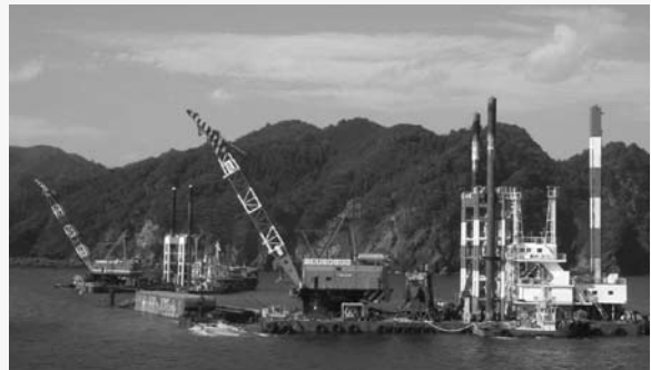
岩手県 釜石港ケーソン撤去(讃岐号、鷺羽号)
