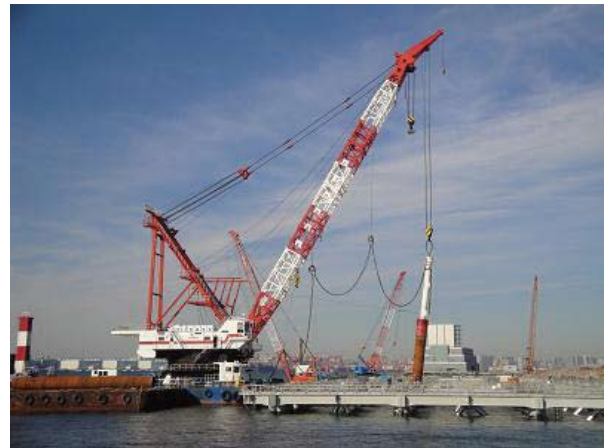
後行杭打設状況「第十八御在所号」
