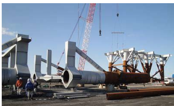
ジャケット工場製作状況(平面組立)
