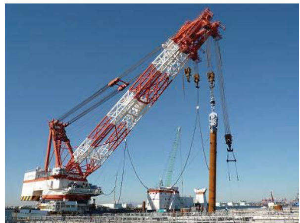
後行杭打設状況「神翔1600」
