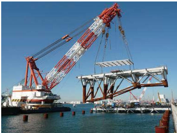
ジャケット据付状況
