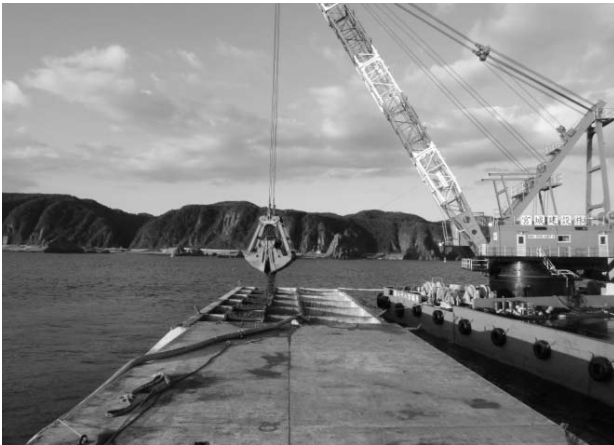
写真-8 ケーソン中詰作業状況
