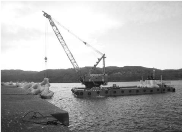
写真-7 消波ブロック据付状況
