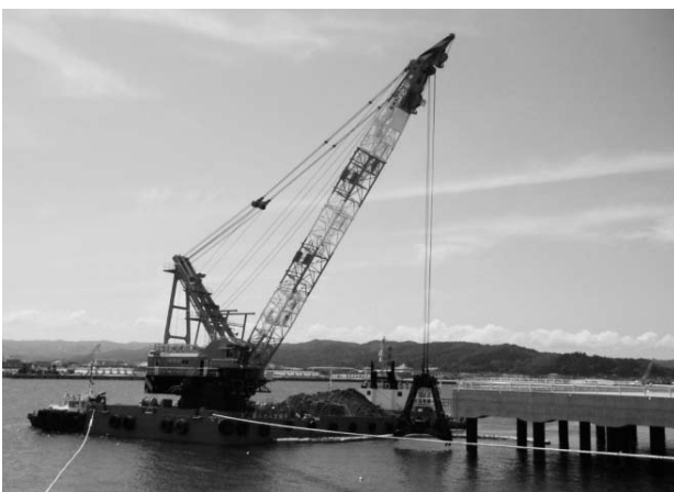
写真-9 浚渫作業状況
