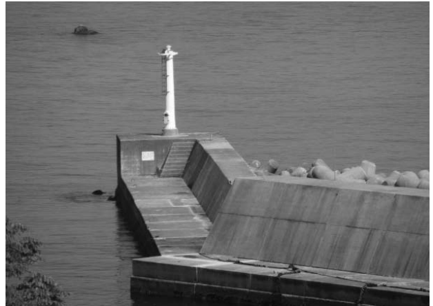
写真-4 小袖灯台
