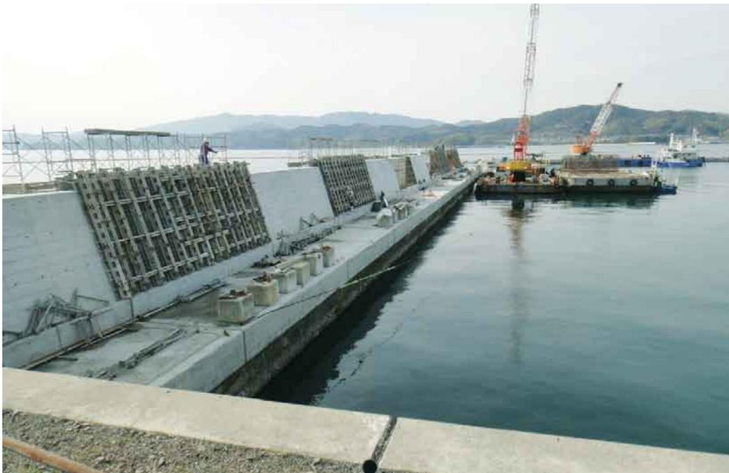
N7直轄土砂処分場上部工施工状況
