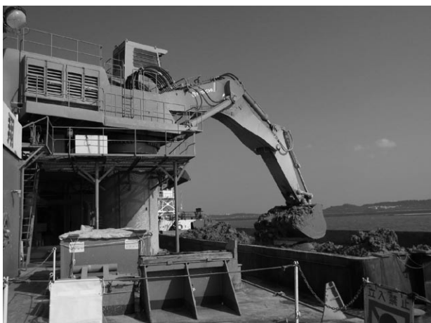
土運船からの揚土作業
