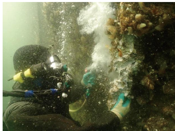
港湾施設の点検状況
