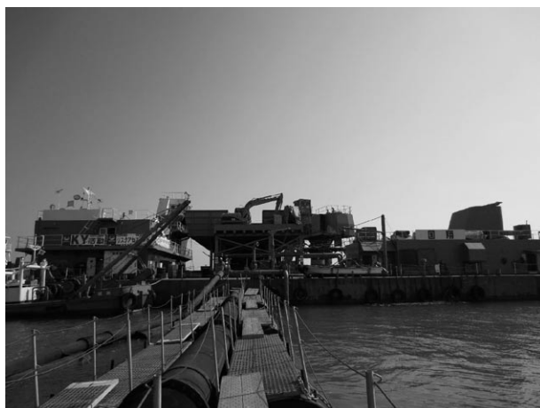
空気圧送船からの排砂管
