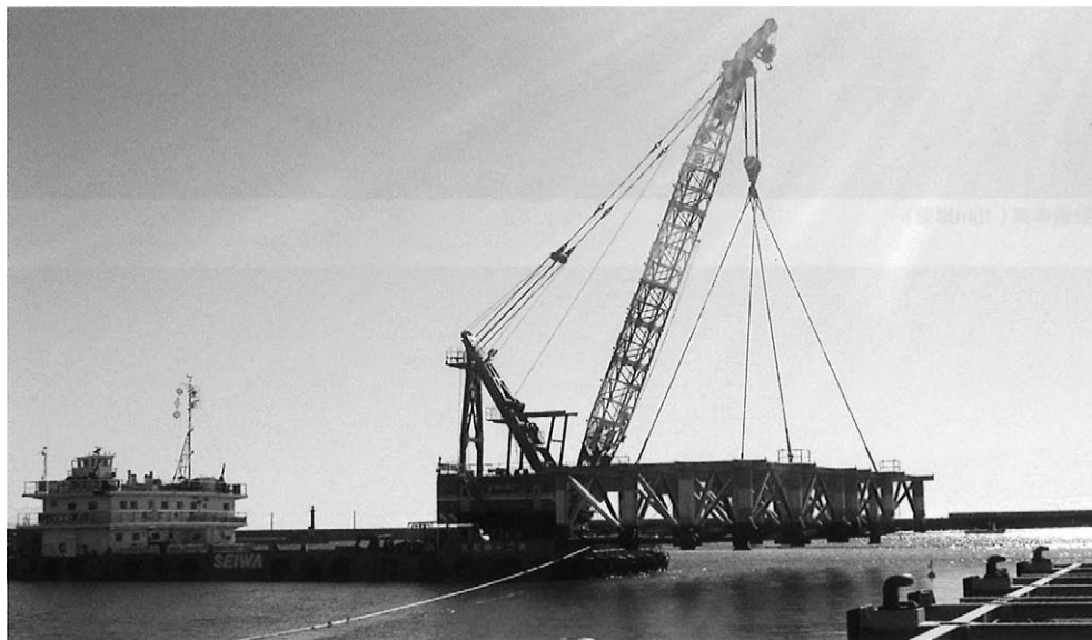
焼津漁港 鋼製ジャケット据付工事
