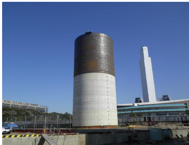
鋼殻付きケーソン(VIP2部)
