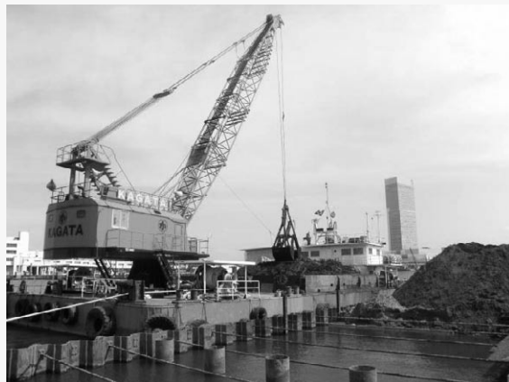
新潟港(西港区)信濃川左岸緑地護岸工事
