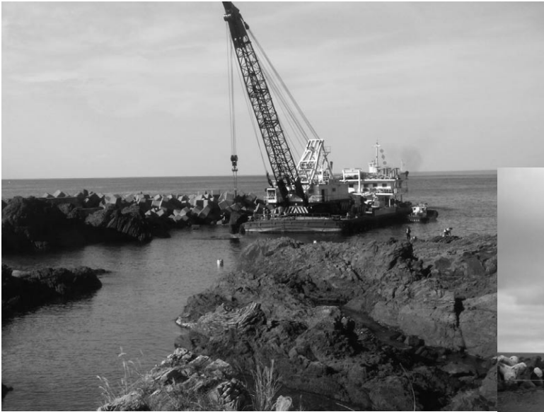
室戸市新村漁港災害復旧作業 (消波ブロック撤去据付) 航路の幅=約 20m 水深=- 2.5m
