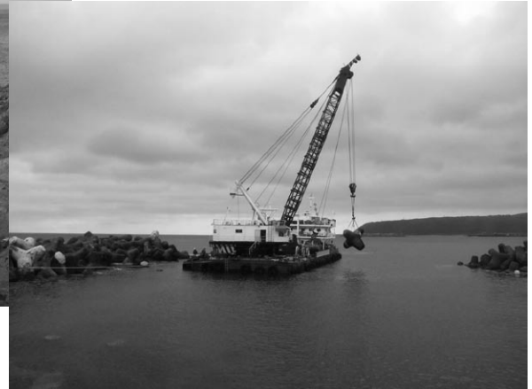
室戸市新村漁港災害復旧作業 (消波ブロック撤去据付) 航路の幅=約 20m 水深=- 2.5m
