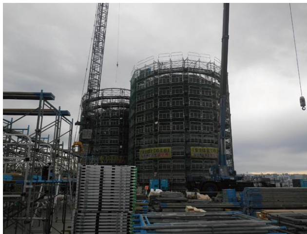
鋼殻付きケーソンの製作状況
