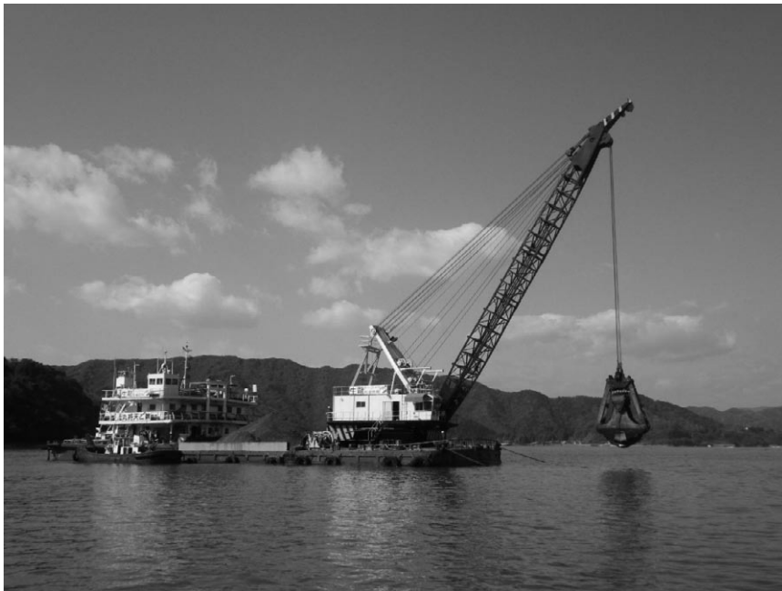
(宇佐漁港) グラブ 10m 3 を使用して航路浚渫作業中
