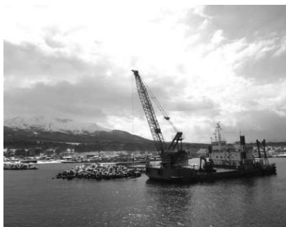
砂原漁港 ブロック据付
