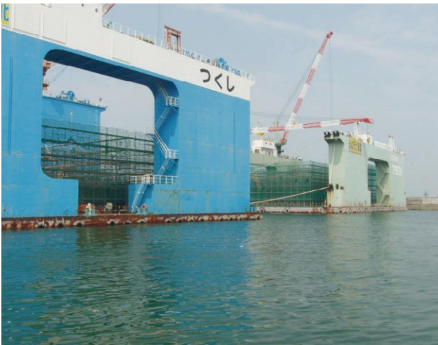
ケーソン進水状況
