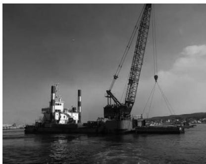
砂原漁港 ケーソン据付
