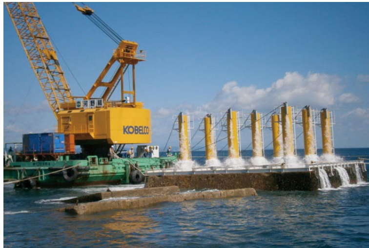
転用ケーソン浮上状況
