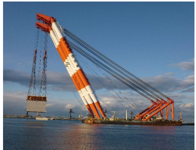
ケーソン吊り降ろし状況
