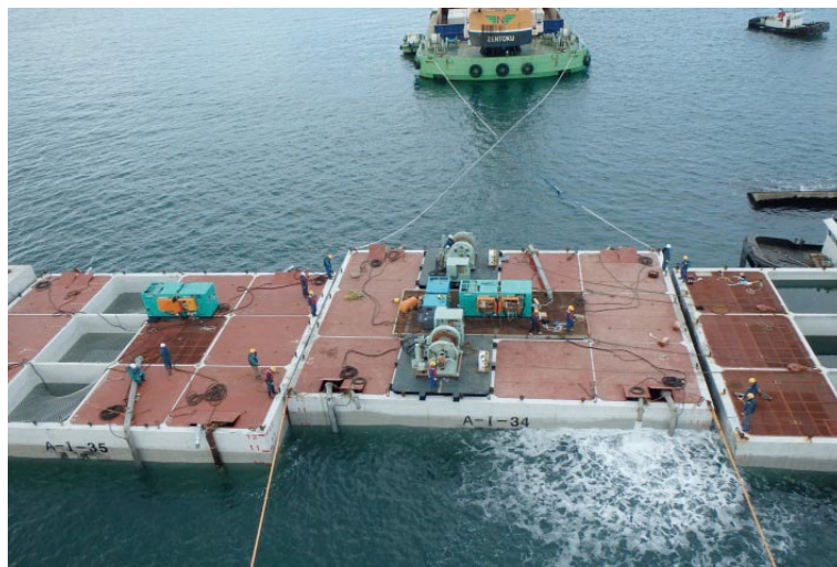
ケーソン据付状況
