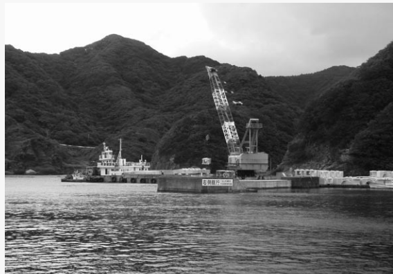
妻良漁港災害復旧工事においてブロック据付作業
