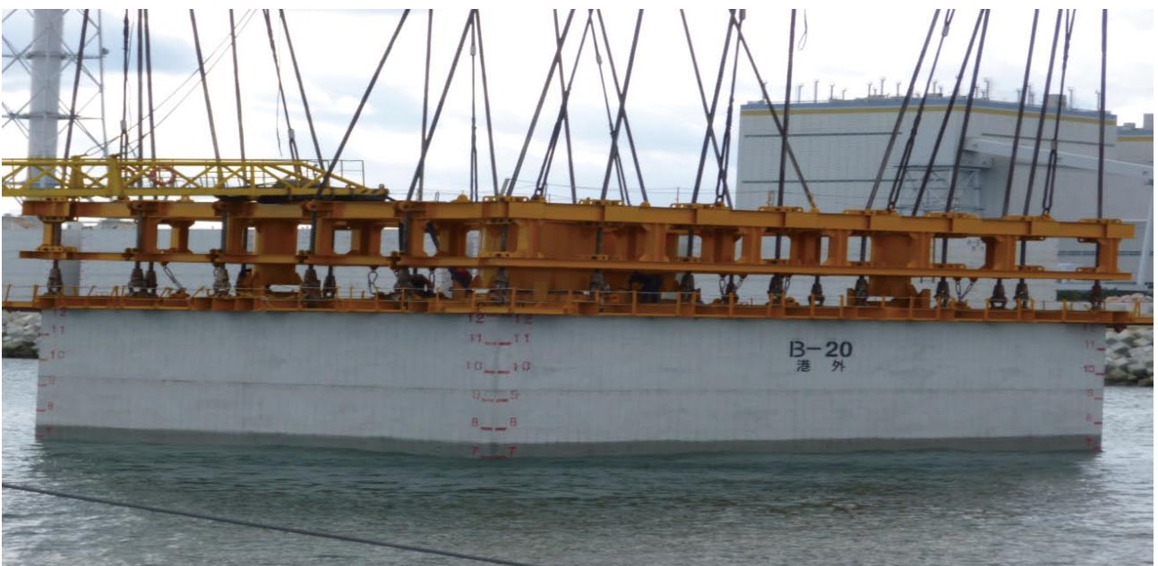
ケーソン吊り降ろし状況(吊り杵)
