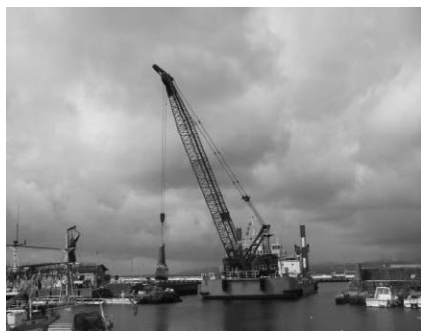
函館漁港 歴史的建造物復旧
