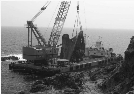
下田港沖神子元島にて座礁船撤去作業
