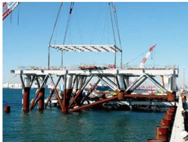
③ 全旋回式起重機船によるジャケット据え付け
