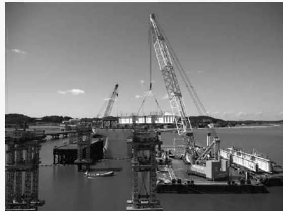
鹿行大橋新橋架設工事
