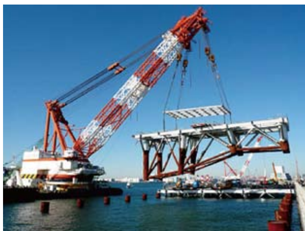
② 全旋回式起重機船によるジャケット据え付け
