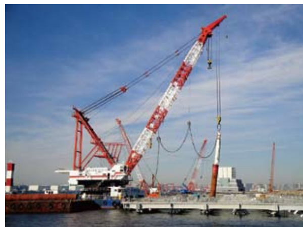
④ 後行杭(斜杭)の打設
