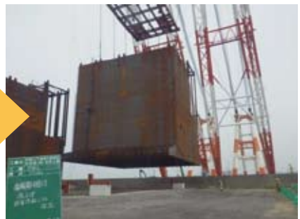
鋼殻据付(製作ヤード:和歌山下津港)
