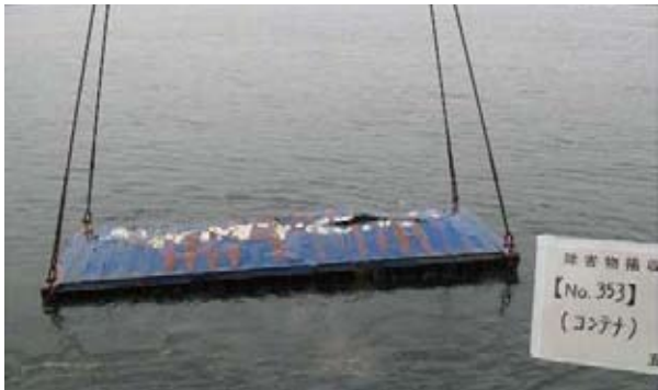
写真3 玉掛けによるコンテナの撤去
