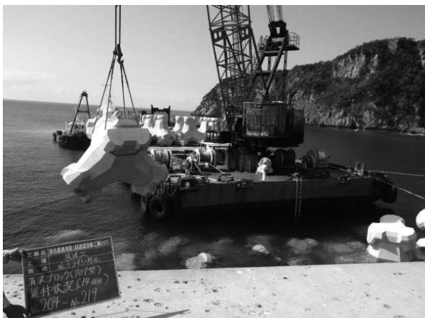
消波ブロック据付
