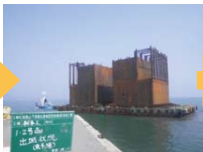
鋼殻運搬(工場~製作ヤード)
