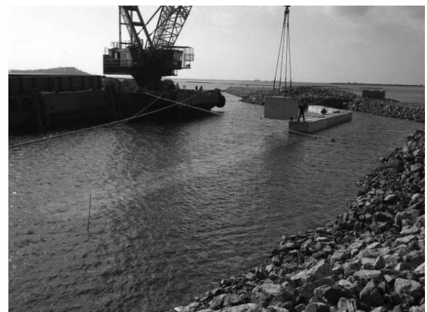
方塊ブロック据付
