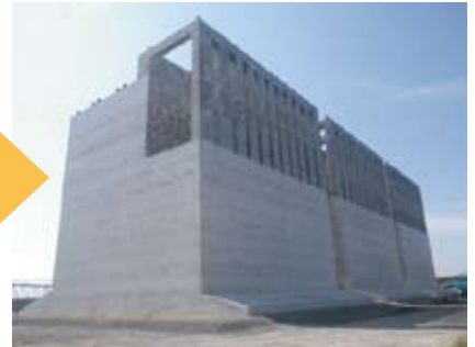
ハイブリッドケーソン完成
