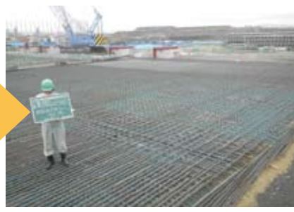
1ロット鉄筋組立
