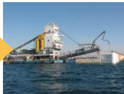
蓋コンクリート打設
