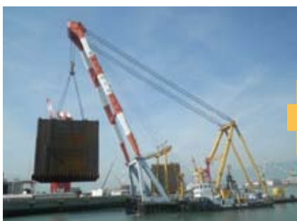
鋼殻積出(工場:愛媛県東予港)
