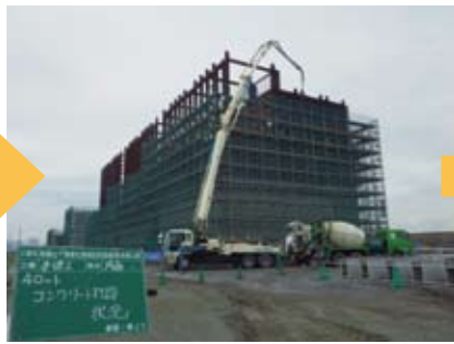
コンクリート打設(4ロット)
