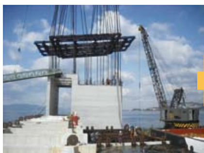
ハイブリッドケーソン据付
