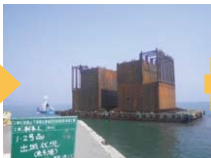
鋼殻運搬(工場~製作ヤード)
