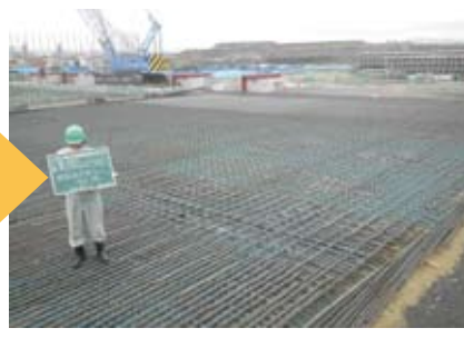
1ロット鉄筋組立
