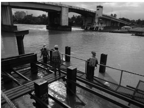
タケタ橋建設現場(仮設工事)
