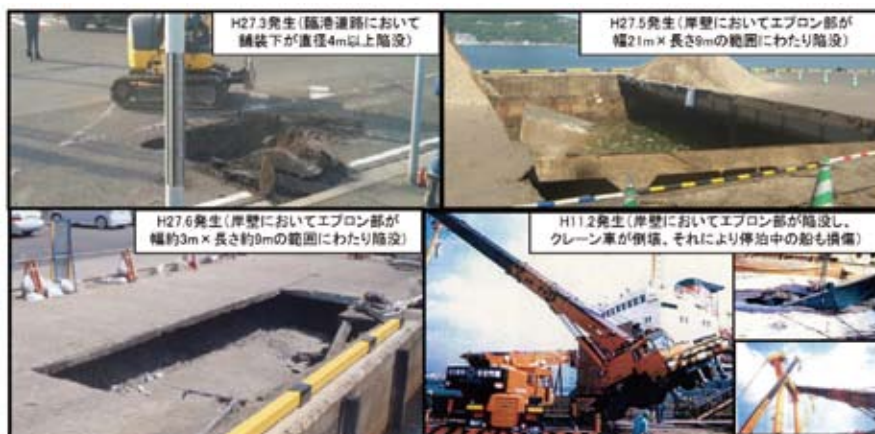
図-8 劣化・損傷による事故事例
