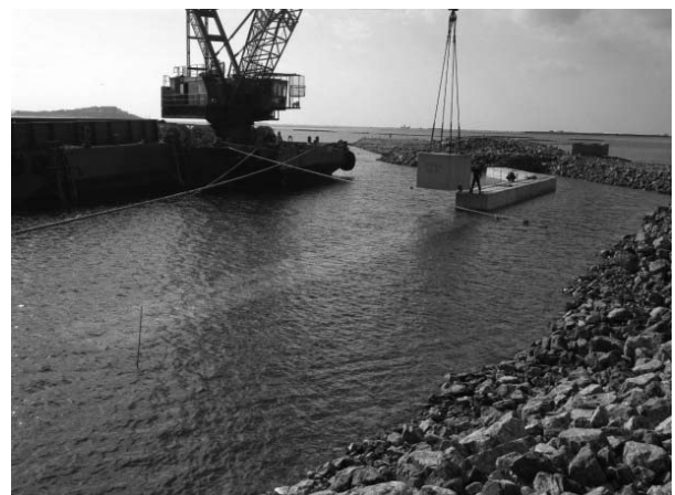
方塊ブロック据付
