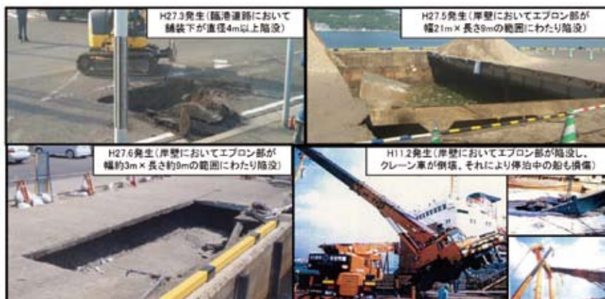
図-8 劣化・損傷による事故事例
