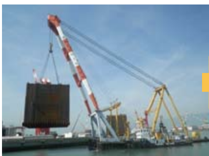
鋼殻積出(工場:愛媛県東予港)
