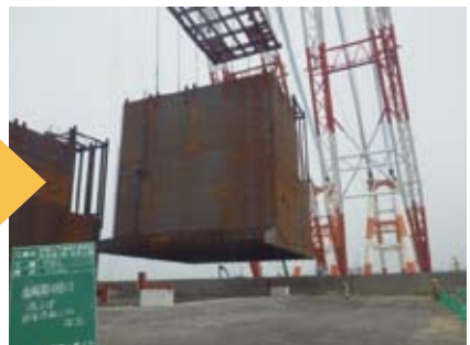
鋼殻据付(製作ヤード:和歌山下津港)
