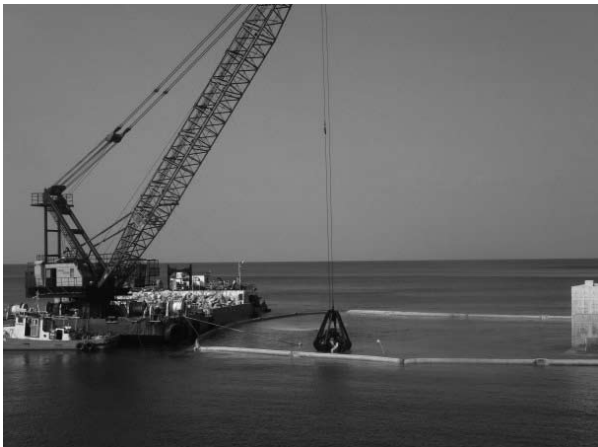
久護-250 防波堤建造 (全景)
