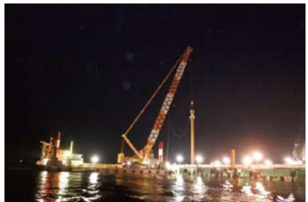
鋼管杭打設状況
