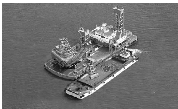
写真-4 施工状況
