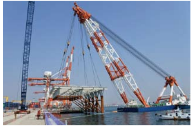
ジャケット据付状況
