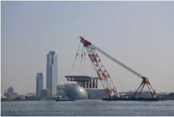
ジャケット曳航状況
