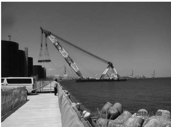
起重機船:鋼板セル据付
