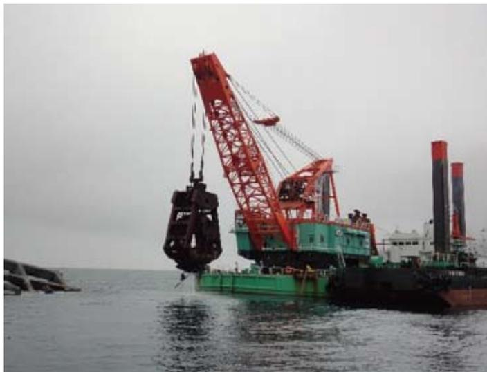
写真-4 硬土盤グラブによる撤去作業
