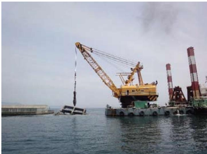
写真-3 砕岩棒によるケーソン破碎
