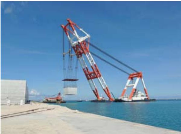
写真3 ケーソン吊降ろし状況
