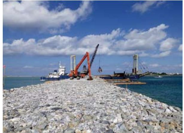
写真4 護岸工事の実施状況(傾斜堤式護岸)
