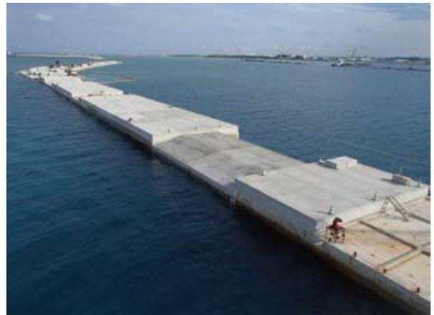
写真5 護岸工事の実施状況(ケーソン式護岸)
