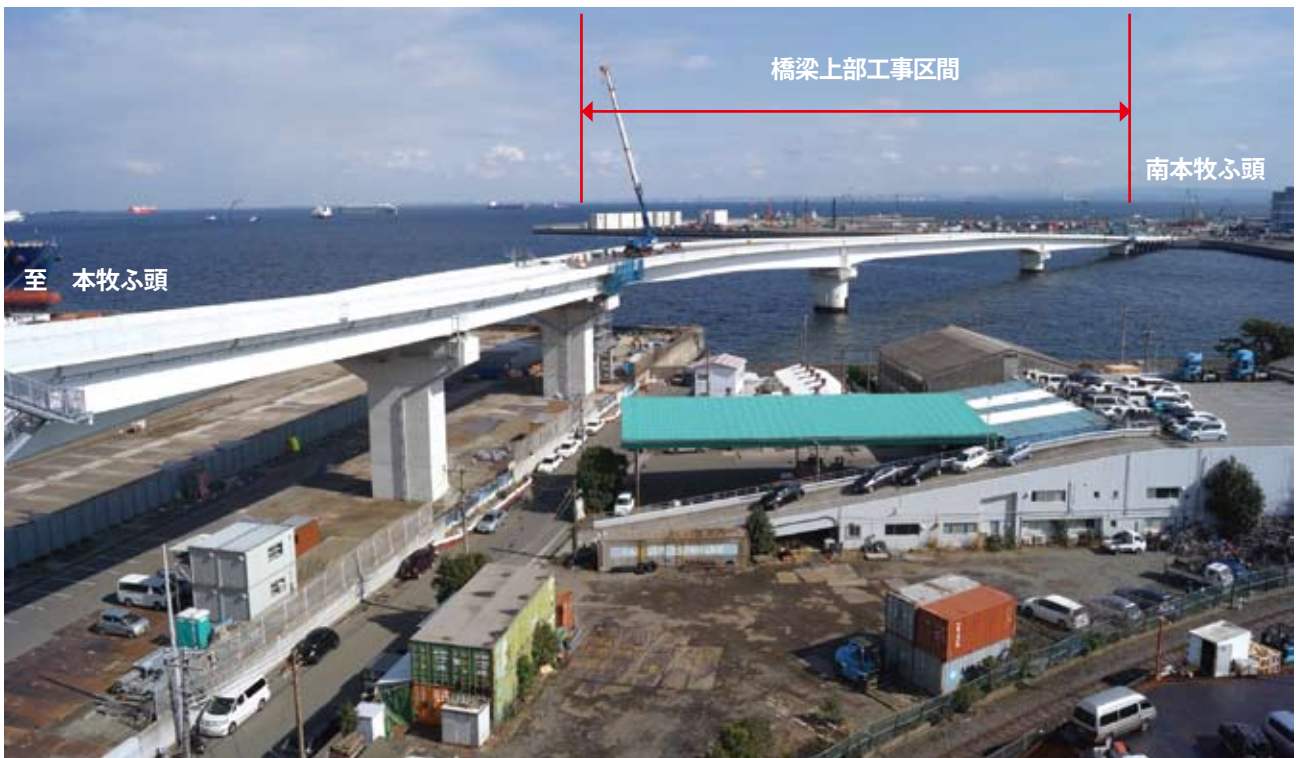
写真-10 架設完了写真
