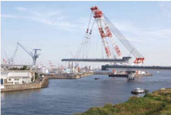
写真-8 大ブロック架設状況-3
