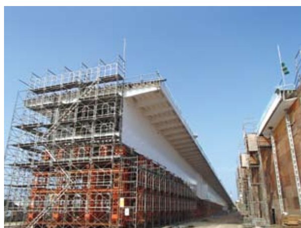
写真-4 箱桁ブロック製作(組立完了)
