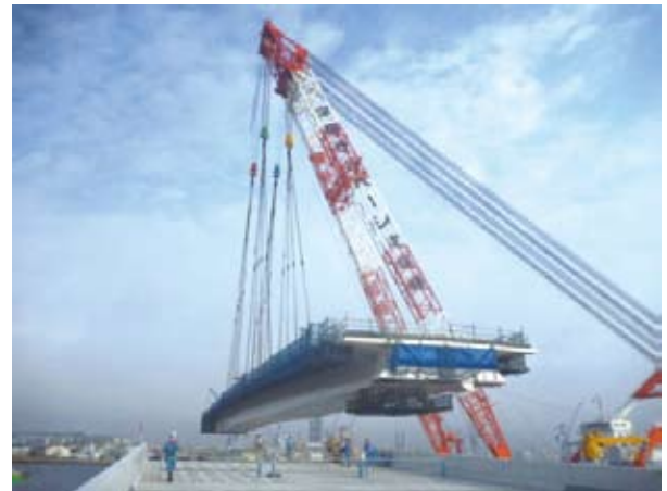
写真-6 大ブロック架設状況-1
