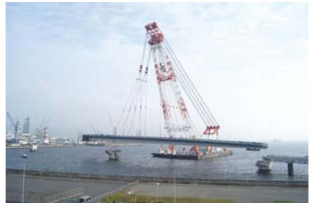
写真-7 大ブロック架設状況-2
