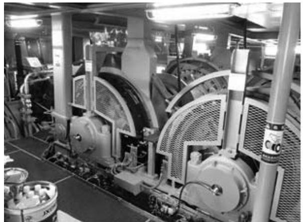
写真-6 クレーン装置
