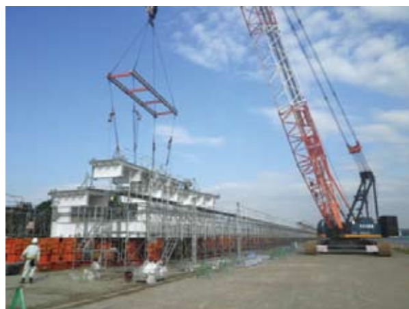
写真-3 箱桁ブロック製作(組立て状況)
