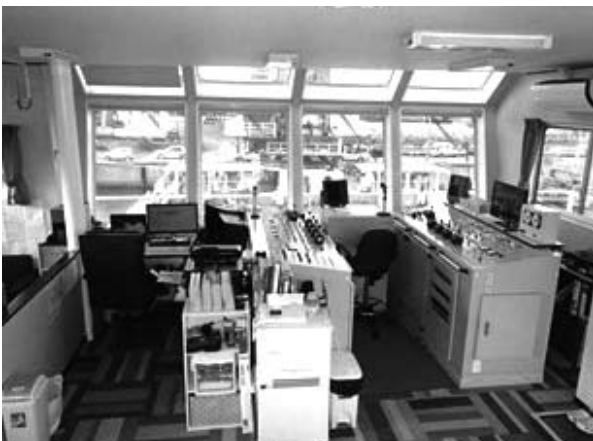
写真-5 3階監視室操作盤
