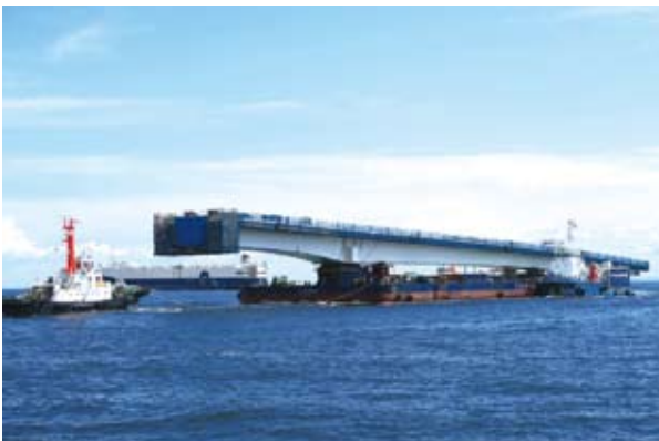
写真-5 大ブロック運搬状況
