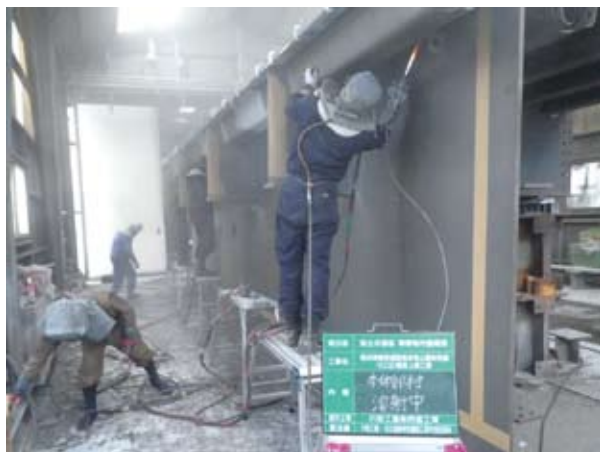
写真-1 箱桁ブロック部材製作
