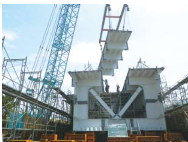
写真-2 箱桁ブロック製作(製作状況)
