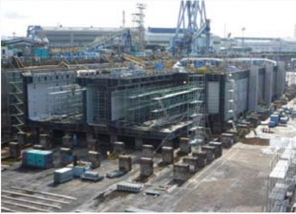
写真-3 ドック内大組立状況
