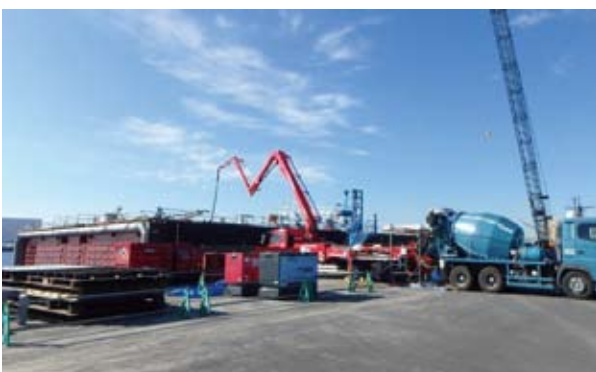
写真-5 3号函浮遊打設状況(千葉港船橋地区)
