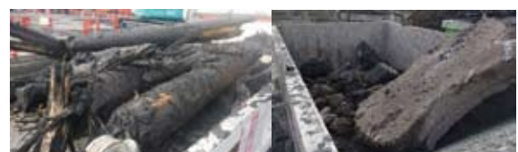
写真-7 支障物(左:松杭、右:割石・舗装版)
