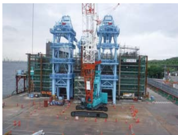
写真-12 中防側ニューマチックケーソン構築状況
