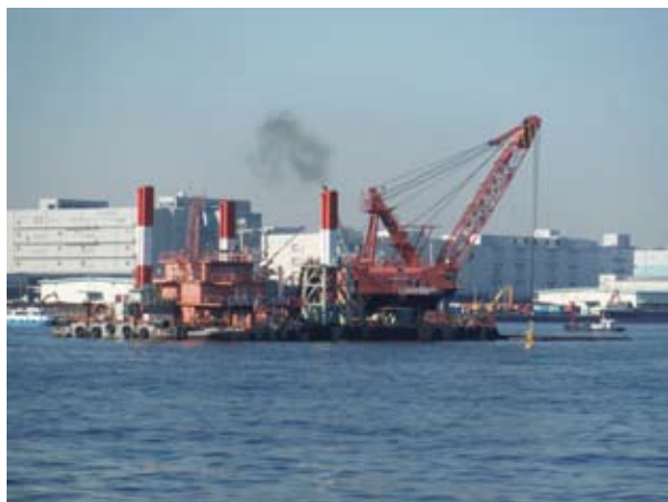
写真-11 2・3号函沈設場所のトレンチ浚渫
