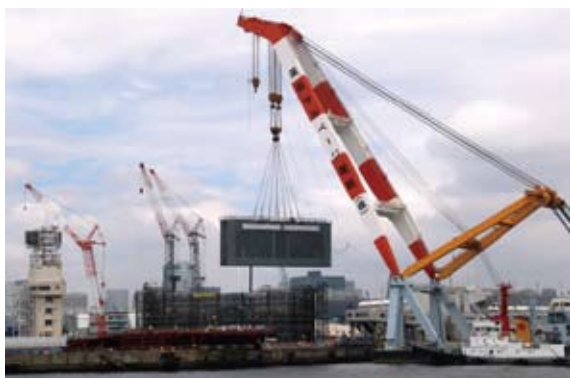
写真-8 端部鋼殻一括架設(10号地側)
