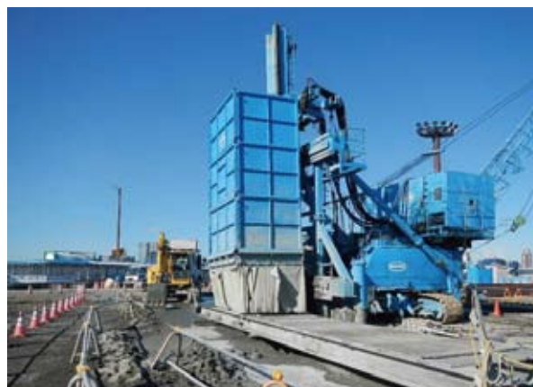
写真-9 連続地中壁工(TRD工法)
