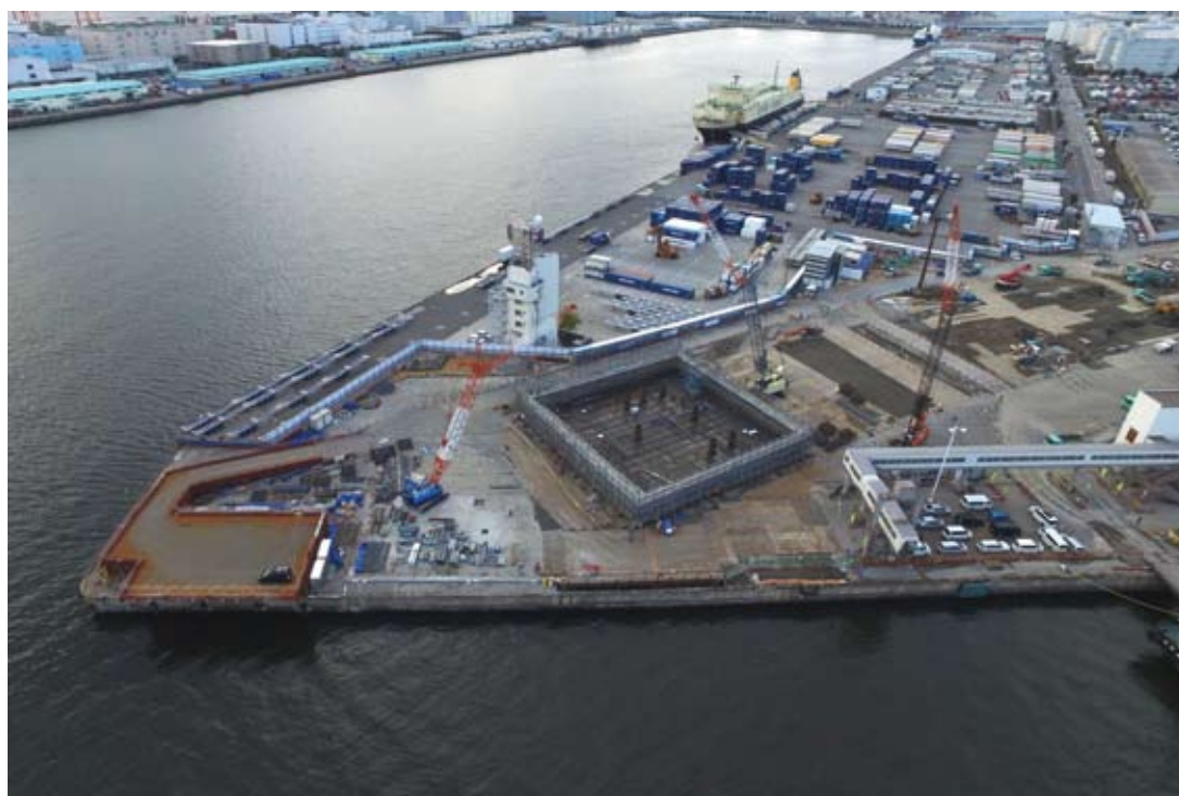
写真-13 10号地側全景
