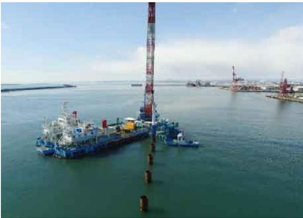
写真-4 鋼管杭打設状況
