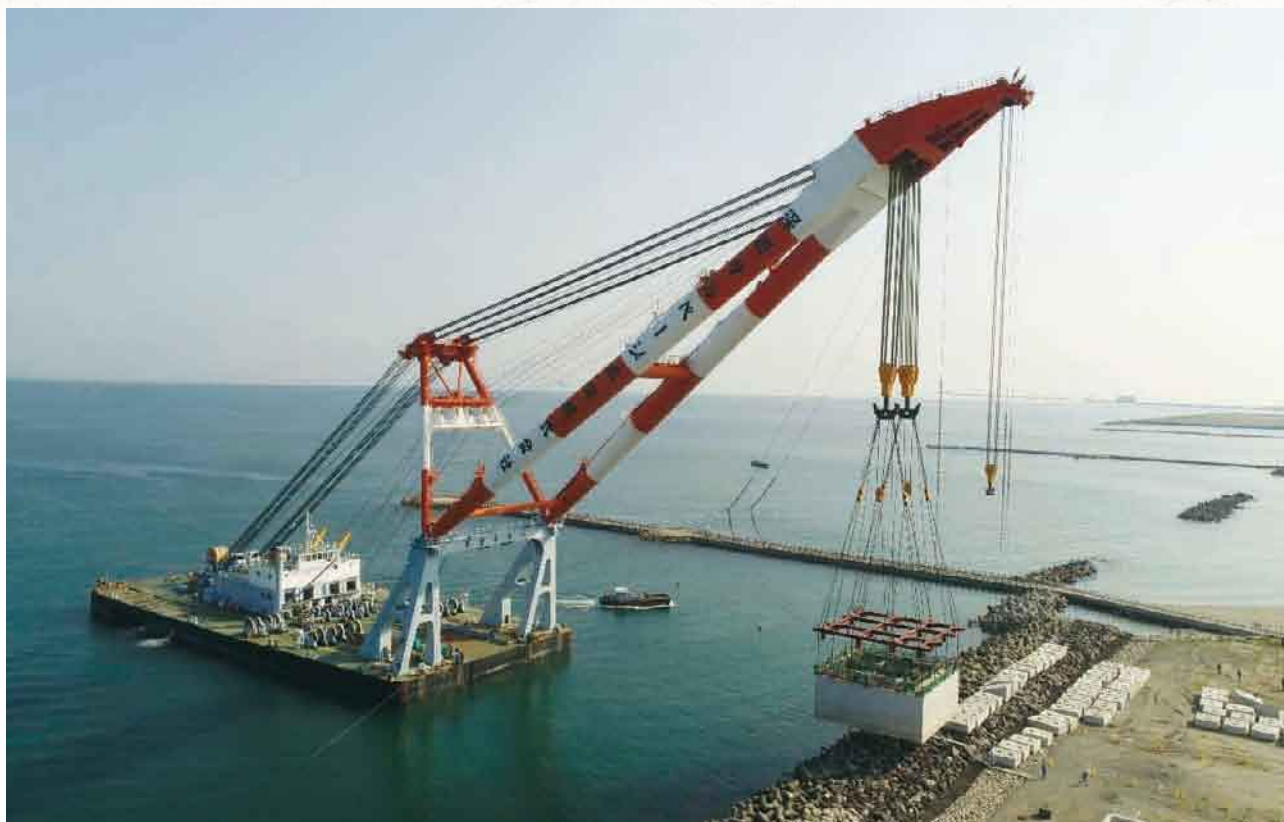
突堤工事におけるケーソン吊上状況
