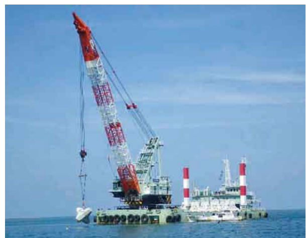
潜堤工事における消波ブロック据付状況
