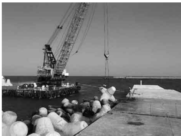
写真-3 ブロック据付状況写真
