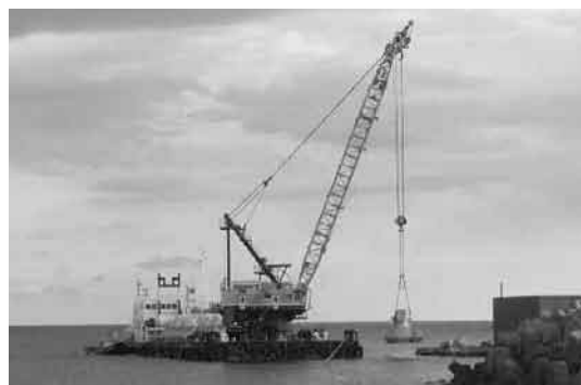
写真-5 ブロック据付状況写真
