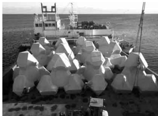
写真-4 ブロック積込状況写真
