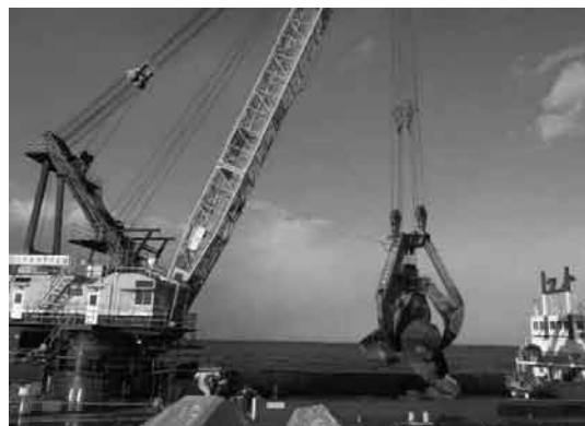
写真-7 ブロック撤去状況写
