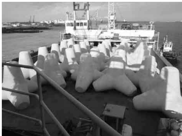
写真-2 ブロック積込状況写
