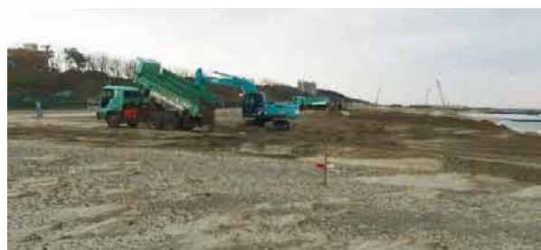
養浜工事における砂の投入状況
