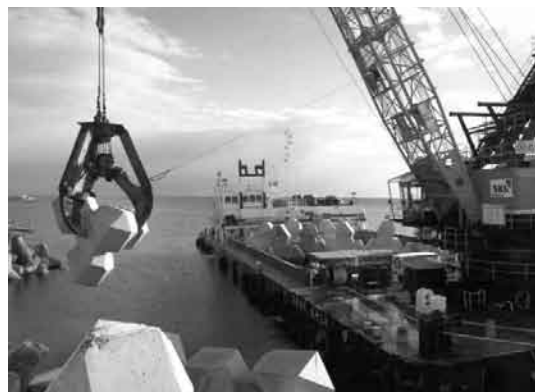
写真-6 ブロック撤去状況写真
