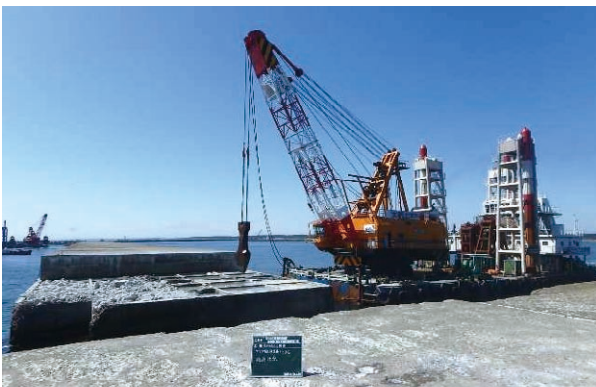
写真6 ケーソン破砕状況 (グラブ浚渫船)
