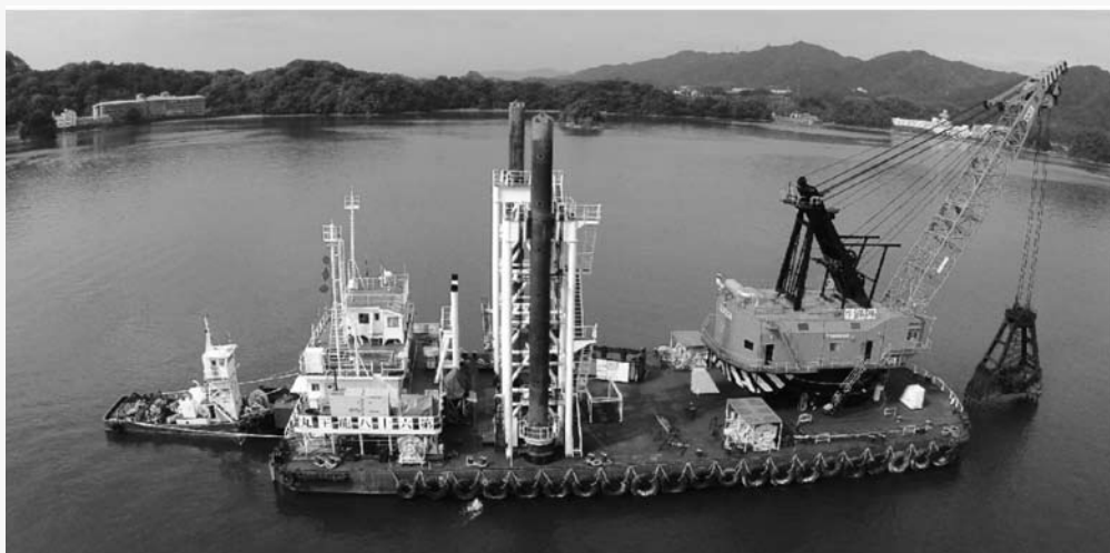
グラブ式浚渫船(25m)兼起重機船(260t吊) 第六十八龍王丸
