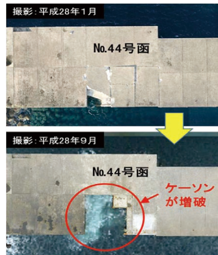
写真5 ケーソンの損壊状況
