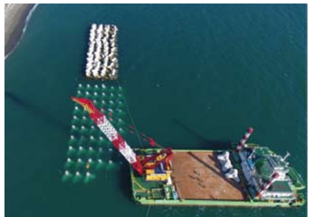
写真②『ブロック据付状況』
