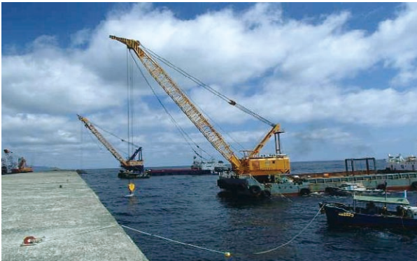
写真10 根固ブロック撤去状況
