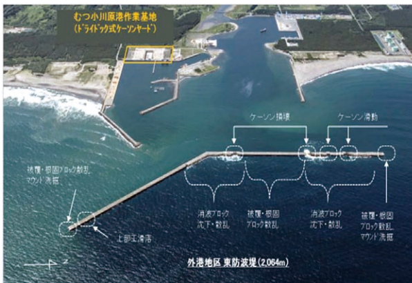
写真1 東防波堤の被災概要
