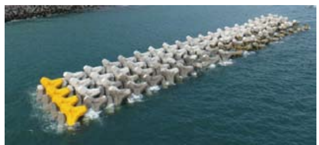
写真③『ブロック据付完了』
