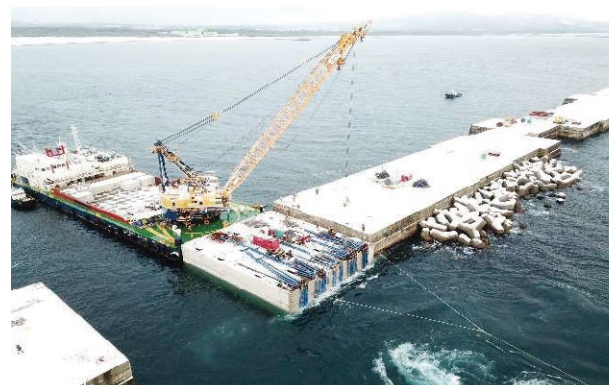
写真9 ケーソン据付状況 (No. 23号函)
