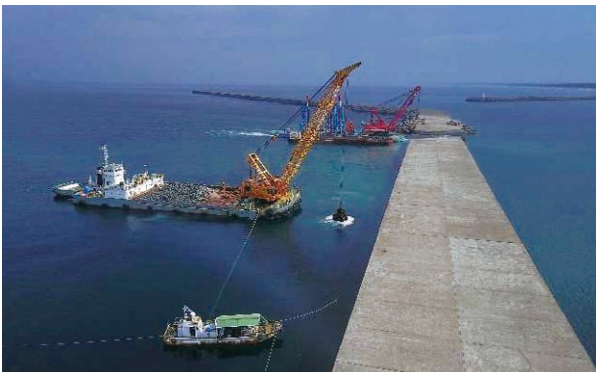
写真11 基礎捨石投入、補修状況
