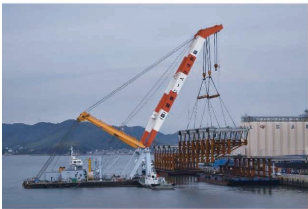
図-8:ジャケット浜出し
