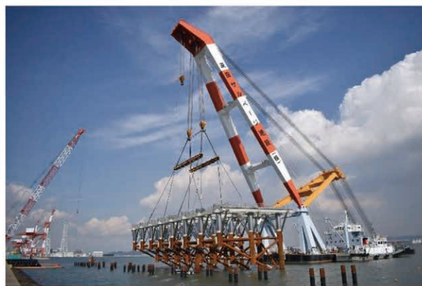
図-9:ジャケット据付①
