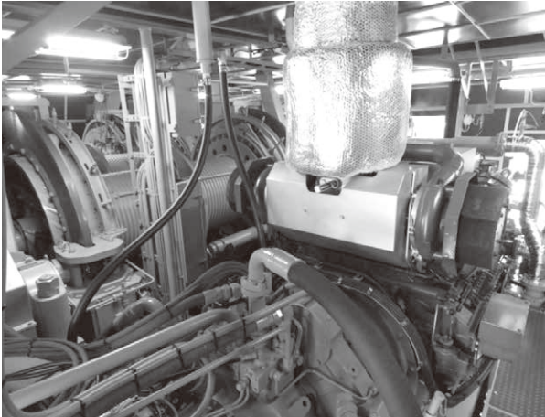
写真-4 クレーン機関内部
