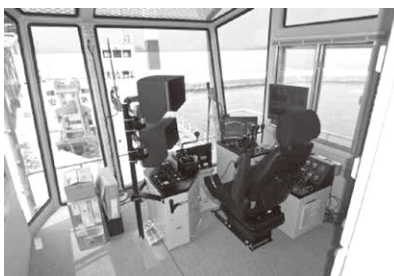
写真-6 操縦室(モニター設置)
