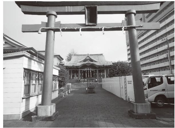
穴守稲荷神社(ただいま工事中)
