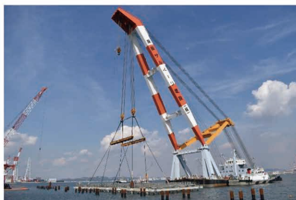
図-11:ジャケット据付③
