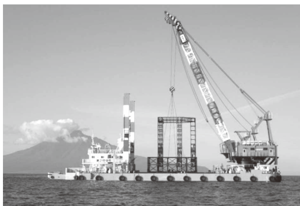
写真-2 鋼製魚礁沈設(利尻島沖合)
