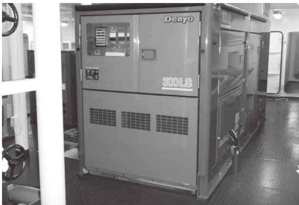
写真-14 主発電機(デンヨー DCA-300LSK)
