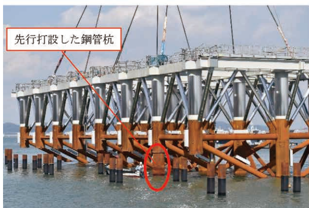
図-10:ジャケット据付②
