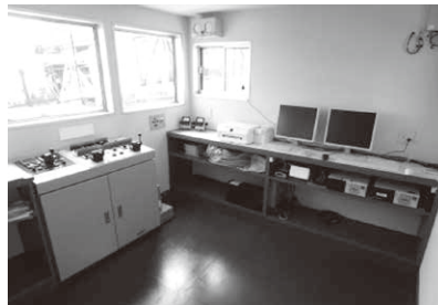
写真-7 3F操作室
