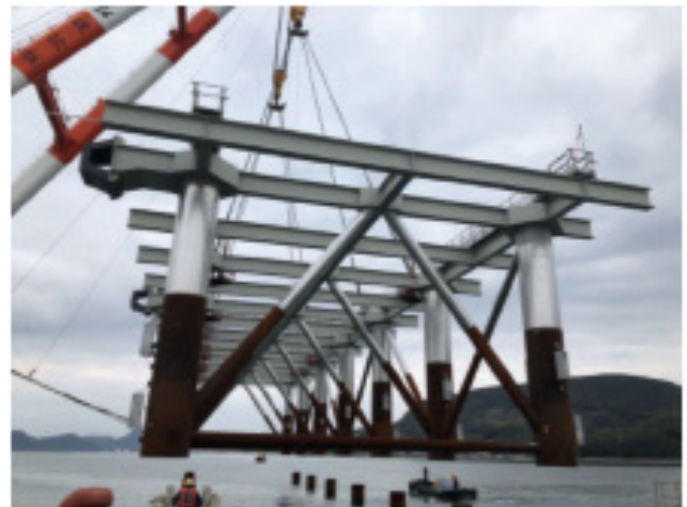
写真-3 ジャケット据付①
