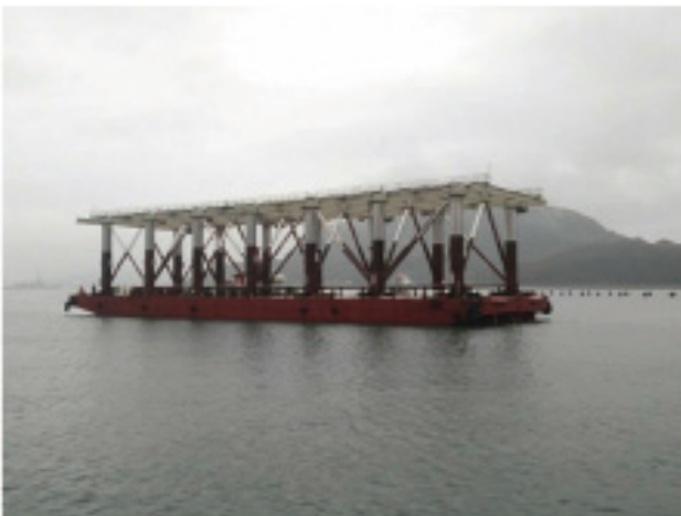
写真-2 ジャケット運搬
