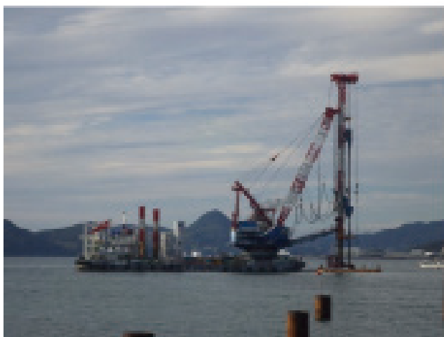
写真-1 鋼管杭打設状況
