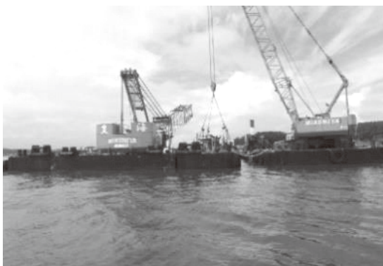
組立作業状況
