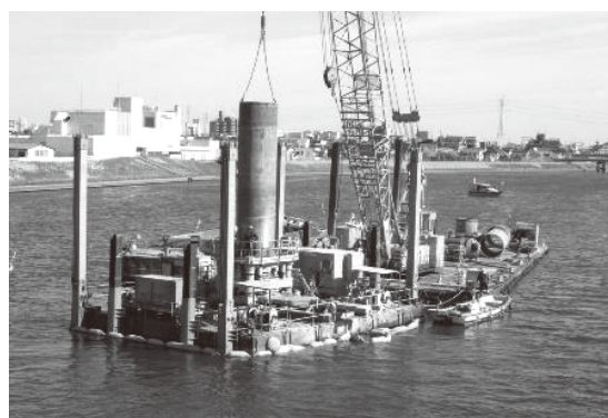
障害物撤去作業
