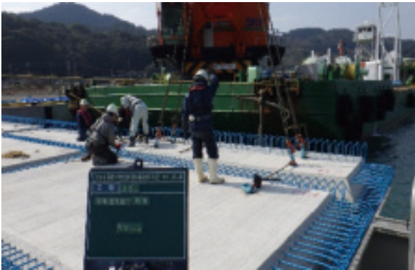
写真-6 床版ブロック据付状況
