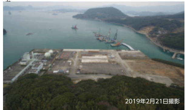
写真-7 施工状況(全景)
