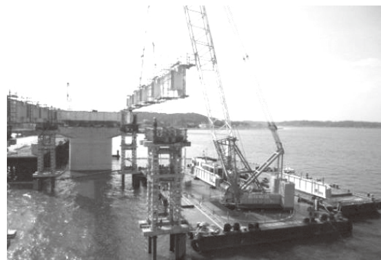
橋梁上部作業状況
