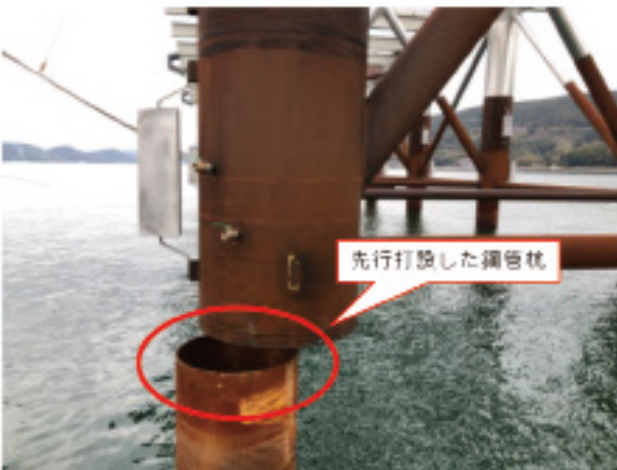
写真-4 ジャケット据付②
