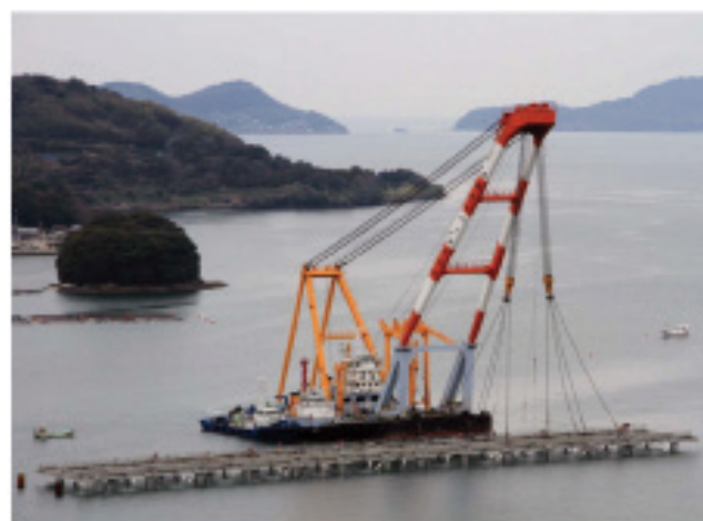
写真-5 ジャケット据付③
