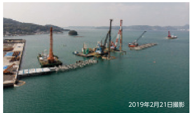
写真-8 施工状況(海上)
