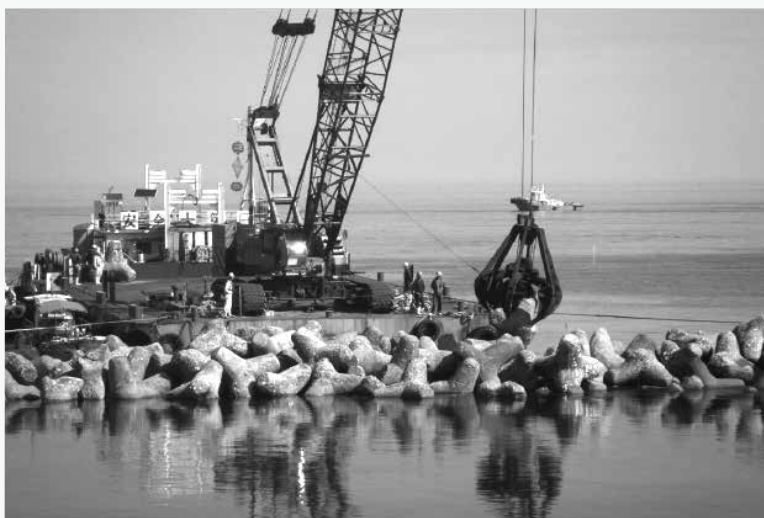
クレーン付台船第八英和号(120t吊)
