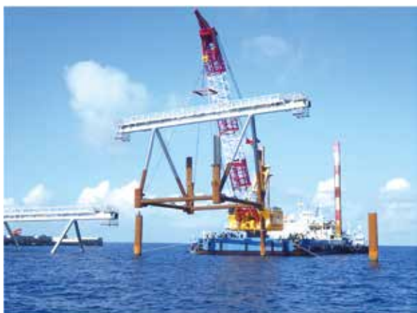
図-9 進入灯橋梁のジャケット据付状況
