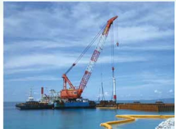
図-6 仮設棧橋築造・鋼管矢板打設状況
