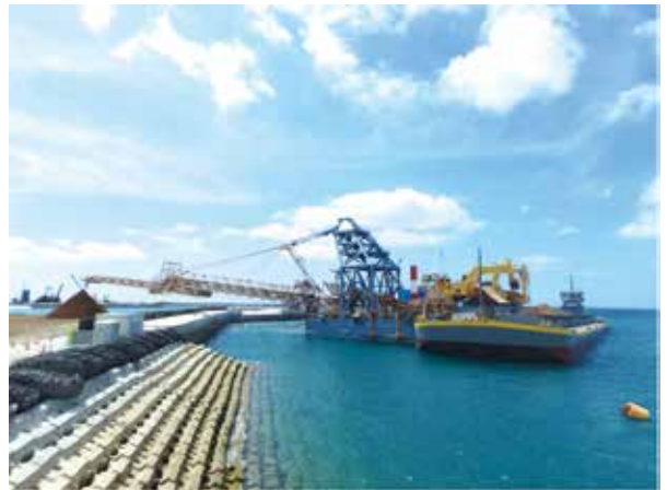
図-7 リクレーマ船による岩ずり揚土作業
