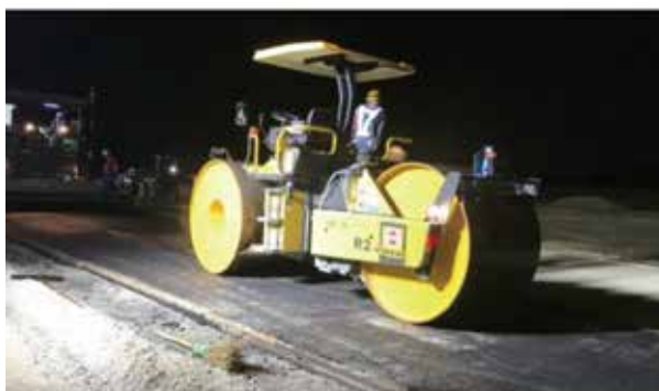
図-8 舗装工・転圧作業
