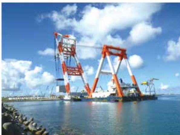
図-5 ケーソン吊降ろし作業状況
