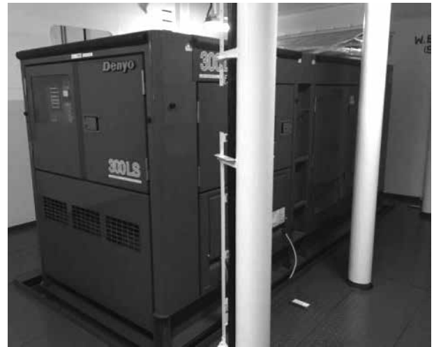
写真-15 主発電機(デンヨー DCA-300LSK)
