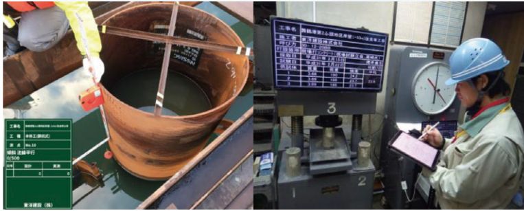
図-15 電子黒板による写真及び 品質管理でのタブレット活用
