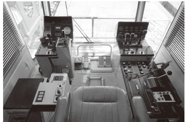
クレーン操縦室操作盤
