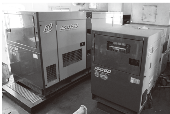
主発電機及び停泊用発電機
