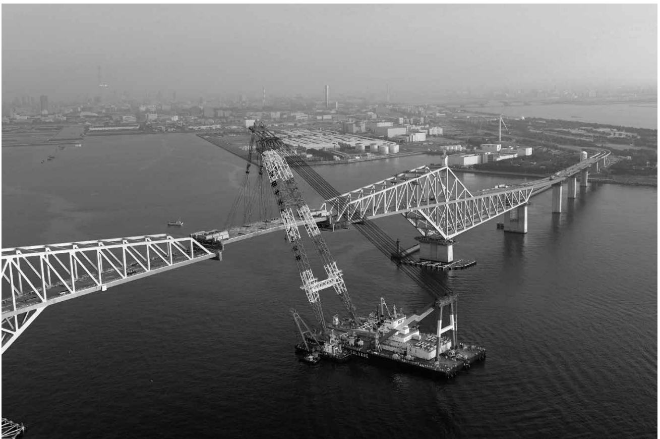
東京ゲートブリッジ中央径間架設閉合
