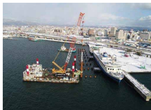
写真-2 鋼管杭打設状況
