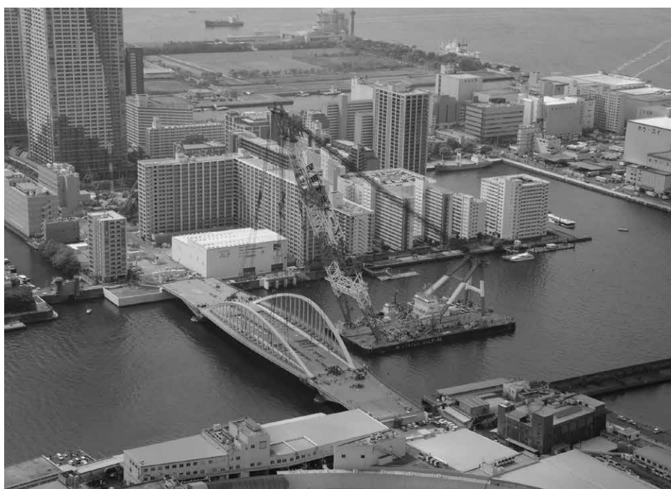
隅田川橋梁架設工事
