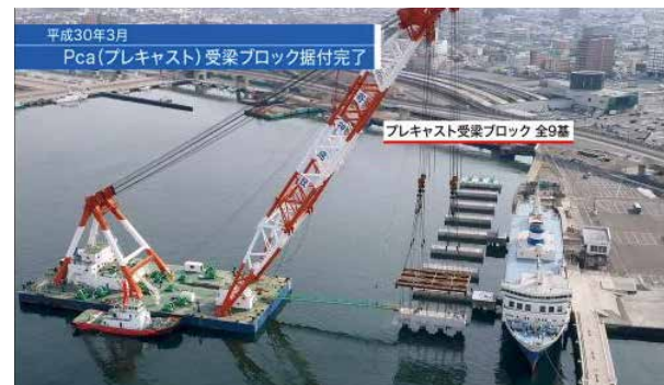
写真-1 大型起重機船によるPca受梁ブロック据付状況
