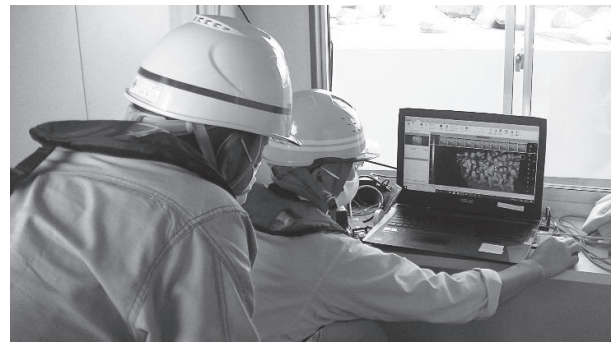
写真-8 ブロック据付指示状況
