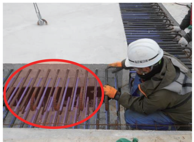
図-16 据付位置調整状況
