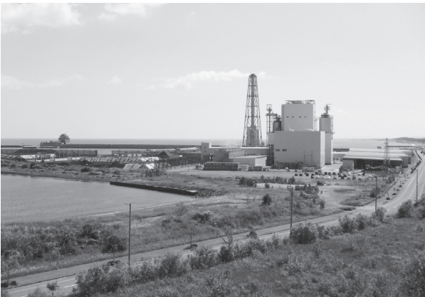
写真⑧ 紋別バイオマス発電所 電気事業者:紋別バイオマス発電(株) 出力:50,000kw 燃料:木質チップ、輸入パーム椰子殻、石炭 営業運転開始:2016年12月1日
