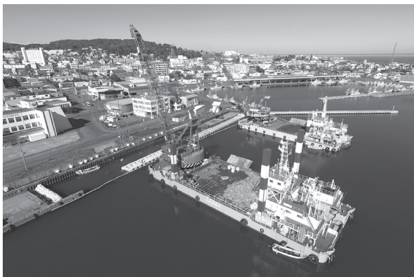
写真② 屋根付き岸壁の施工状況写真 手前:350 t 吊り起重機船兼12m 3 グラブ浚渫・砕岩船 奥:210 t 吊り起重機船兼6 m 3 グラブ浚渫船
