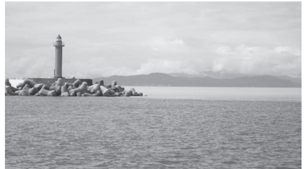
写真-5 濁りにより潜水作業不可
