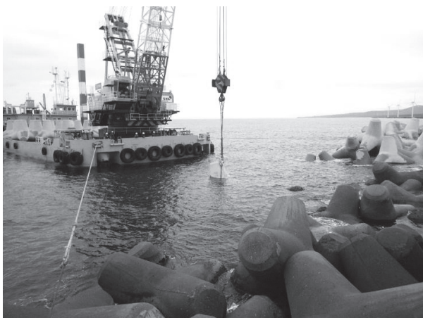
写真-11 ブロック据付状況
