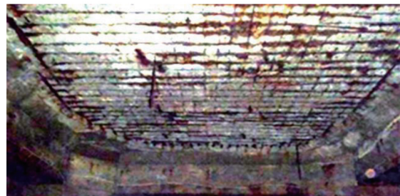
図-3 床版下部の鉄筋露出状況
