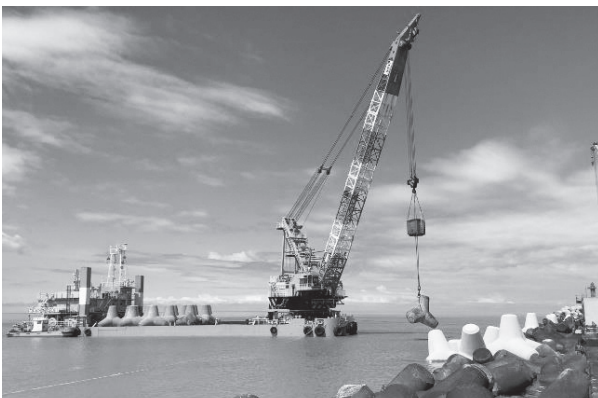
写真-4 ブロック据付状況
