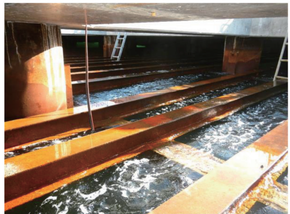
図-15 開口部を設けた栈橋下空間の状況
