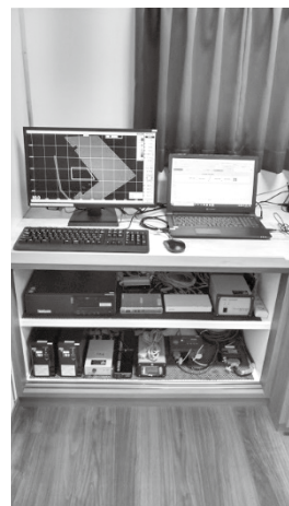
写真1 施工管理システム
