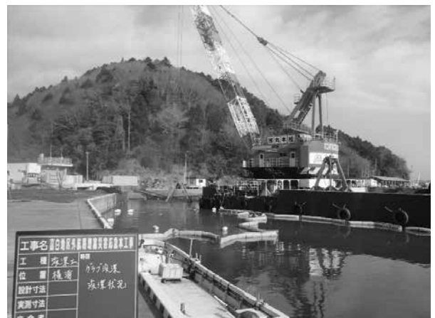
写真-14 浚渫作業(女川町高白地区)
