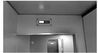
写真4 入浴施設使用ランプ
