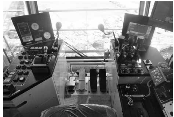
写真- 5 クレーン操作室
