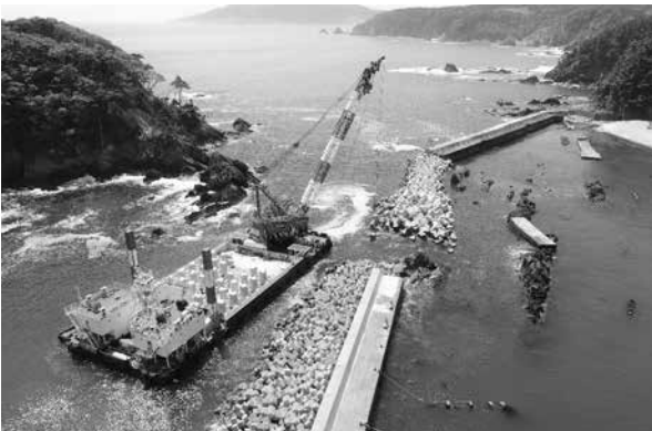
写真-13 消波ブロック据付(石巻市泊浜漁港)
