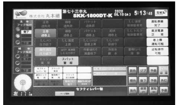
写真- 6 タッチパネル操作盤
