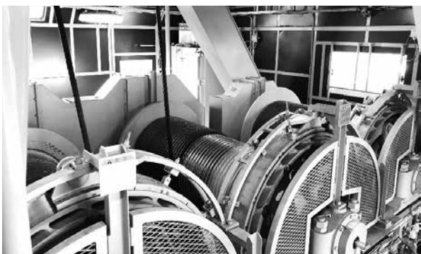
写真-4 クレーン機関室内部
