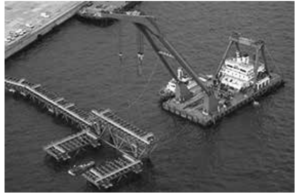
ジャケット据付
