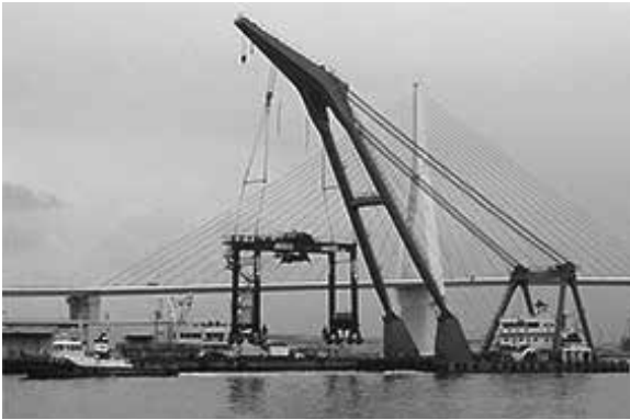
トランスファークレーン運搬
