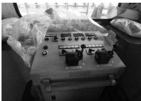
写真-6 スパッド・ウインチ操作盤
