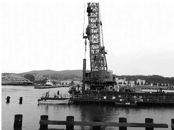
写真-15 鋼矢板建込
