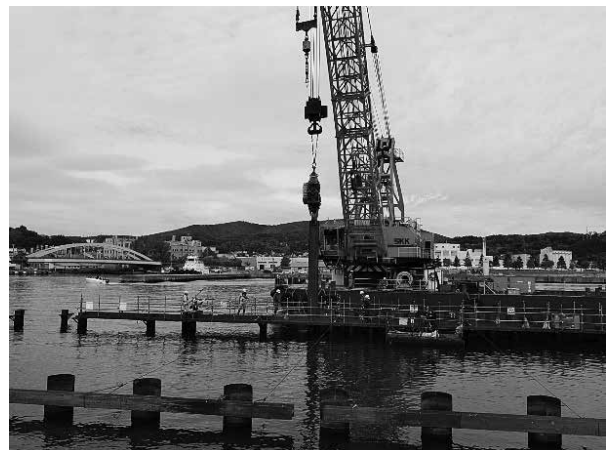
写真-16 鋼矢板打設
