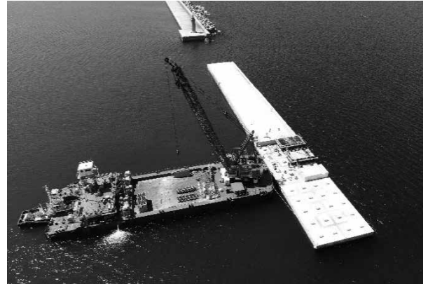
写真-14 上部型枠脱型
