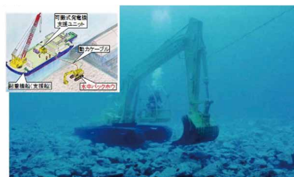
図-2 ICT機械施工について
