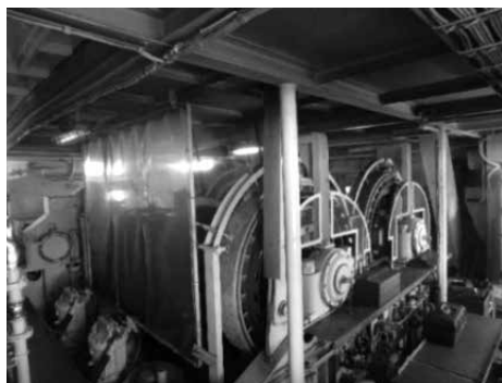
写真-2 クレーン機関室内部
