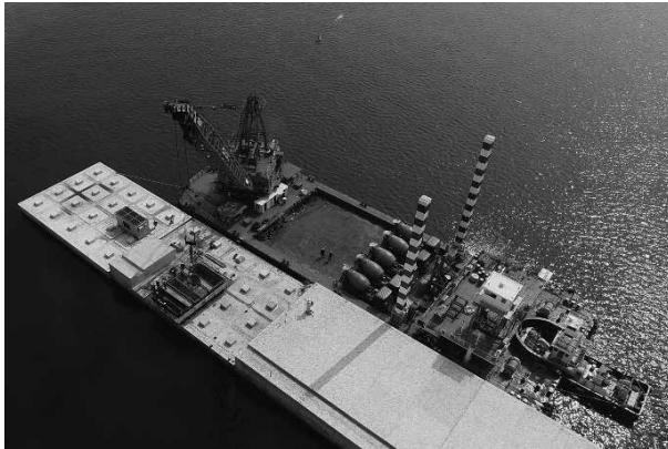
写真-13 生コン打設
