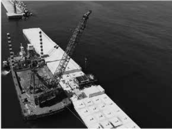
写真-11 上部型枠建込
