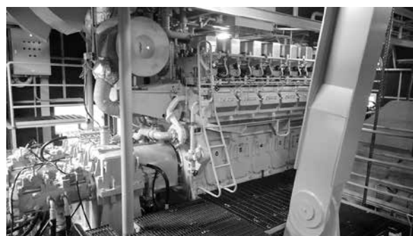
写真-6 ディーゼルエンジン(クレーン)
