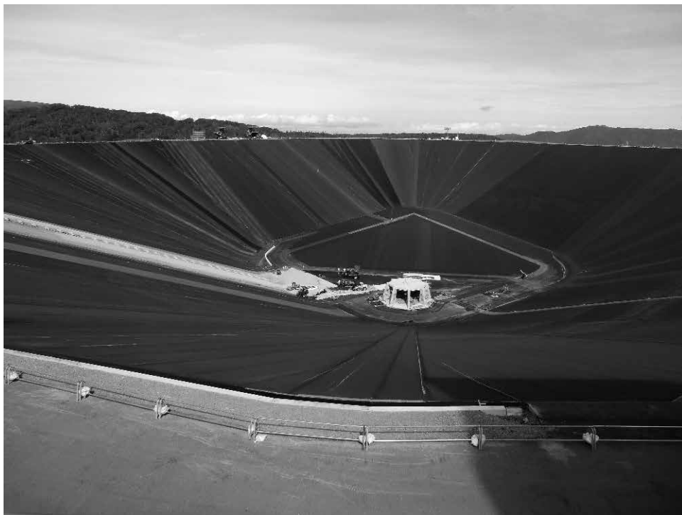
写真1 建設中の京極発電所 上部調整池(2012年9月撮影) (中央部が取水口)
