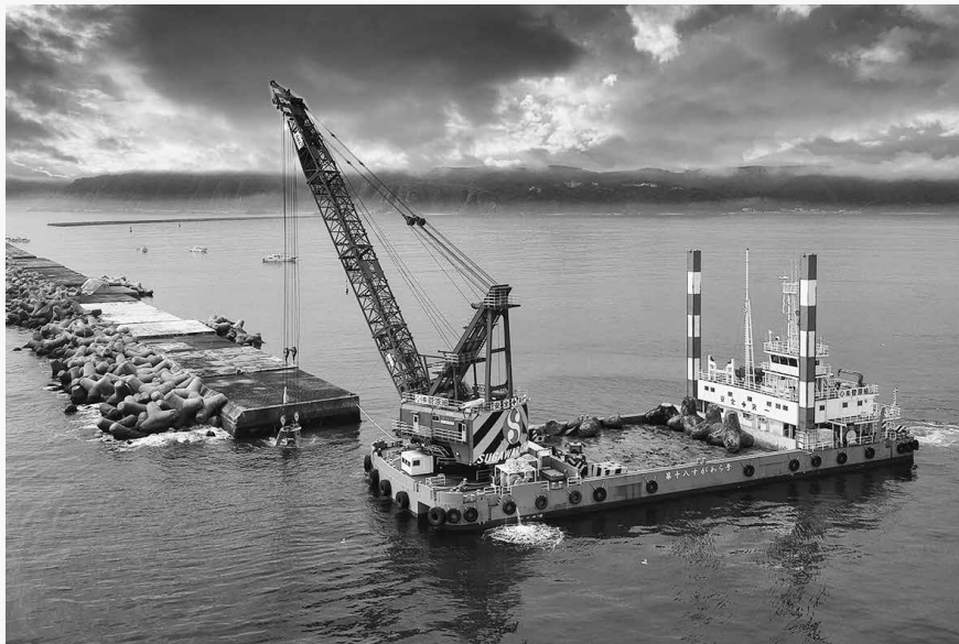
久慈港 64t消波ブロック撤去 状況
