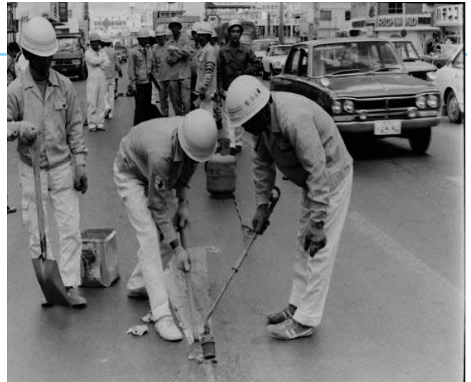
【ナナサンマル:1978年】 日本への復帰6年後に施工された。 提供沖縄建設新聞
