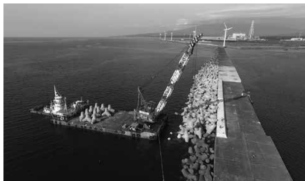
【酒田港での施工状況】
