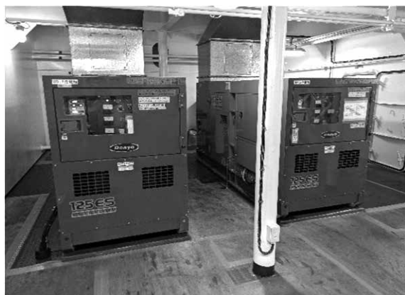
発電装置 (125kVA 2基)
