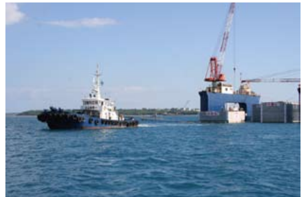
平良港ケーソン製作工事 ケーソン進水状況
