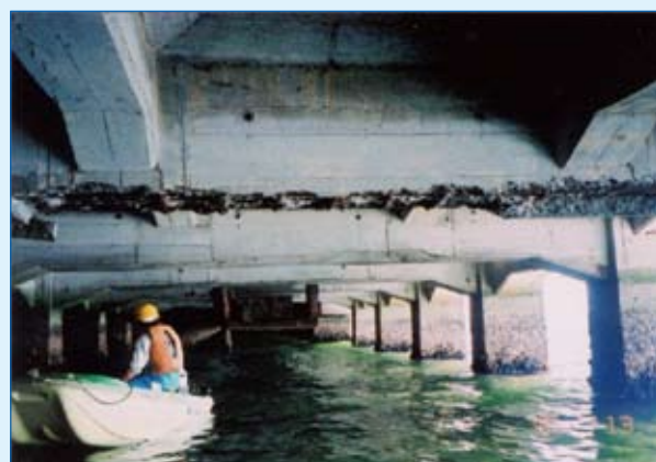
写真1 栈橋上部工の劣化事例
