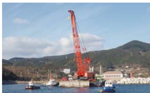
丸尾漁港ケーソン据付状況
