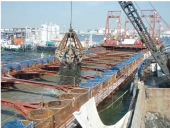
図-8 中詰石投入の施工状況②
