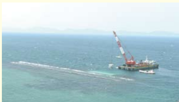
ブロック設置作業(米子市富益地先)
