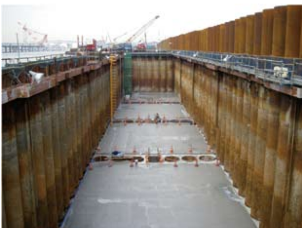
図-16 水替作業完了状況図
