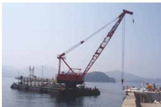
被覆ブロック据付
