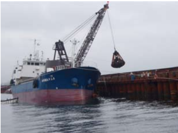
図-7 中詰石投入の施工状況①
