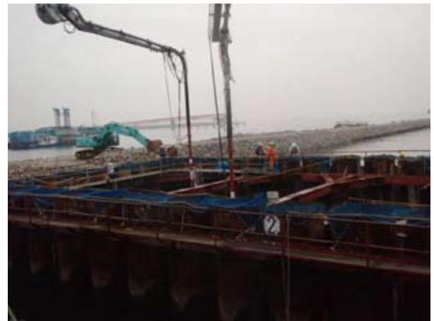
図-13 底盤コンクリート打設状況
