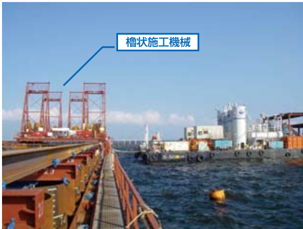
図-10 継手処理工施工状況
