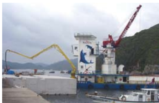
有川港コンクリート打設状況
