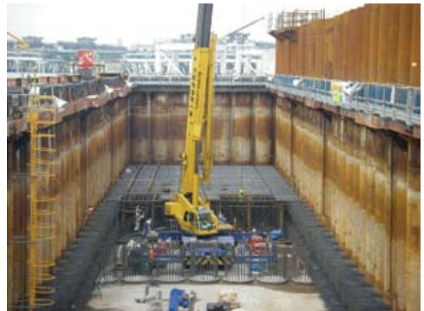
図-17 頂版構造鉄筋組立状況図
