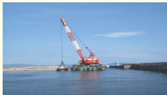
浚渫作業(米子市皆生漁港)
