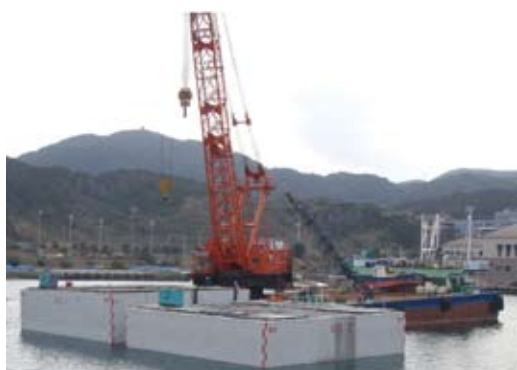
丸尾漁港ケーソン仮置状況
