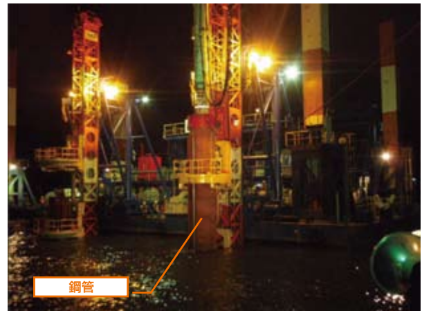
図-5 格点部の杭打設状況(導材台船)
