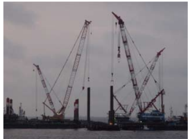
図-6 杭打設状況(夜間作業)
