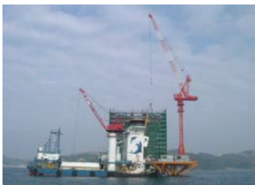
肥前鷹島大橋(仮称)コンクリート打設状況
