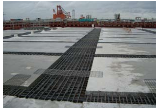
写真-4 鉄筋組立完了(標準版)
