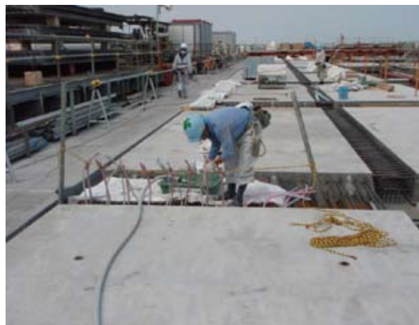
写真-7 グラウト注入状況(杭頭版)
