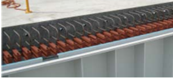
写真-2 箱抜きボックス設置・PCa床版据付
