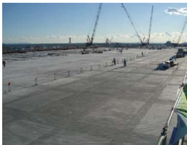
写真-9 床版施工状況近景
