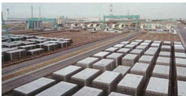
写真-1 仮置き状況
