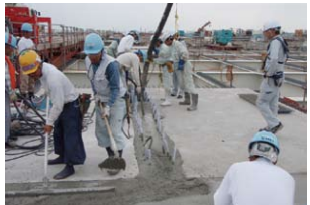
写真-5 打設状況(杭頭版)
