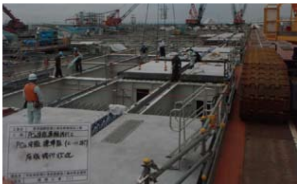
写真-3 PCa床版据付状況
