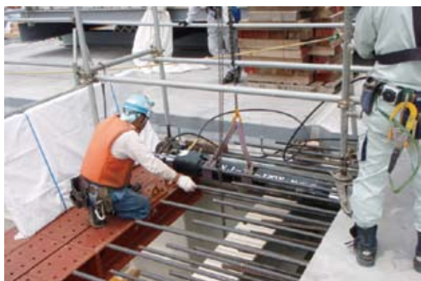
写真-6 PC緊張状況
