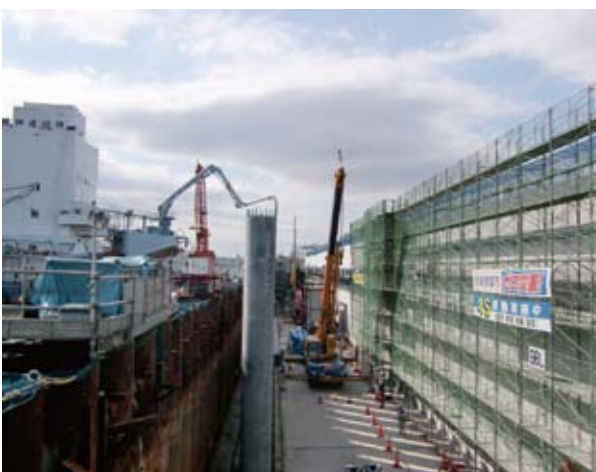
写真-2 中詰めコンクリート打設状況
