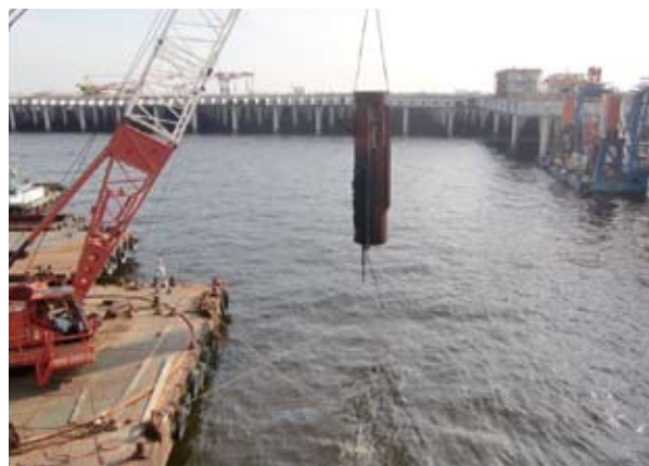
写真-8 引抜いた鋼管矢板の撤去状況
