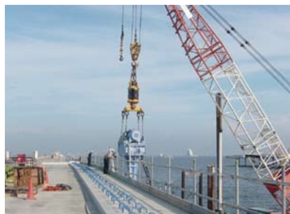
写真-7 パイロハンマーによる引抜状況
