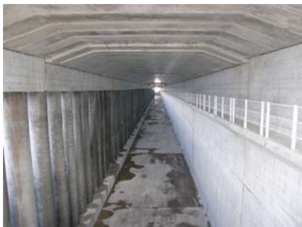
写真-5 鋼管矢板井筒 注水前
