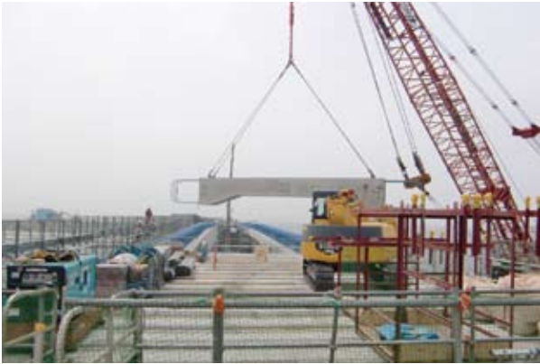
写真-4 PC桁架設状況(2)
