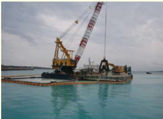
大米2号 浚渫作業
