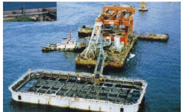
本四連絡橋工事で骨材投入中の「第32関門号」
