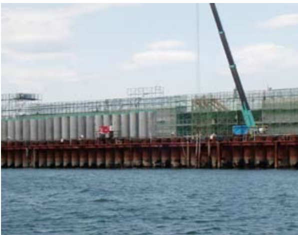
写真-1 スリット柱建て込み状況
