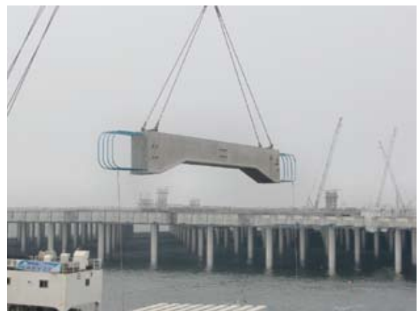
写真-3 PC桁架設状況(1)
