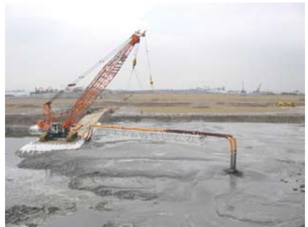
写真一八 軽量混合処理工施工状況
