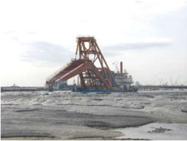
写真一五 管中混合固化処理工施工状況(1)
