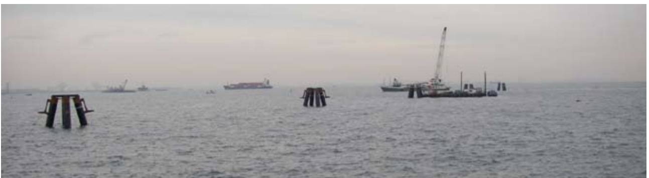
写真一11 進入灯橋梁の現況(平成21年12月、橋脚基礎・鋼管杭)
