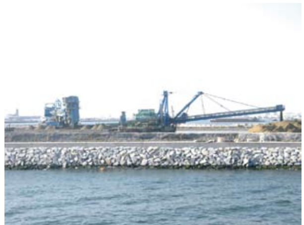
写真一九 堤内揚土施工状況
