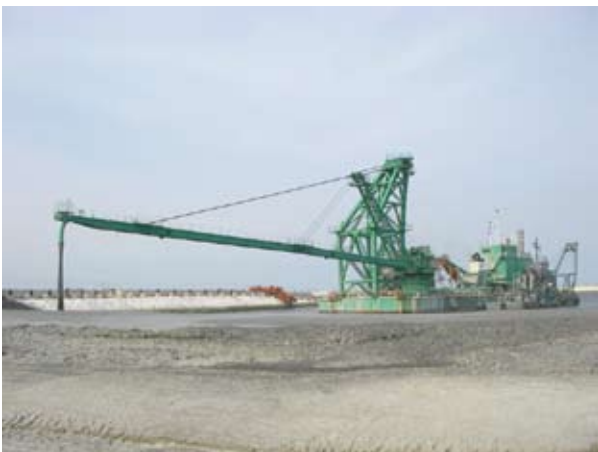
写真一六 管中混合固化処理工施工状況(2)
