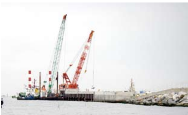
写真一2 ケーソン据付状況
