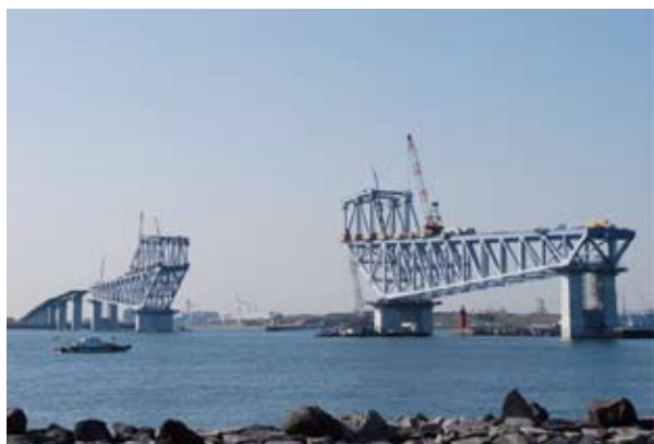
写真-1 大ブロック架設後、上部トラス架設中(H21.11月中旬)
