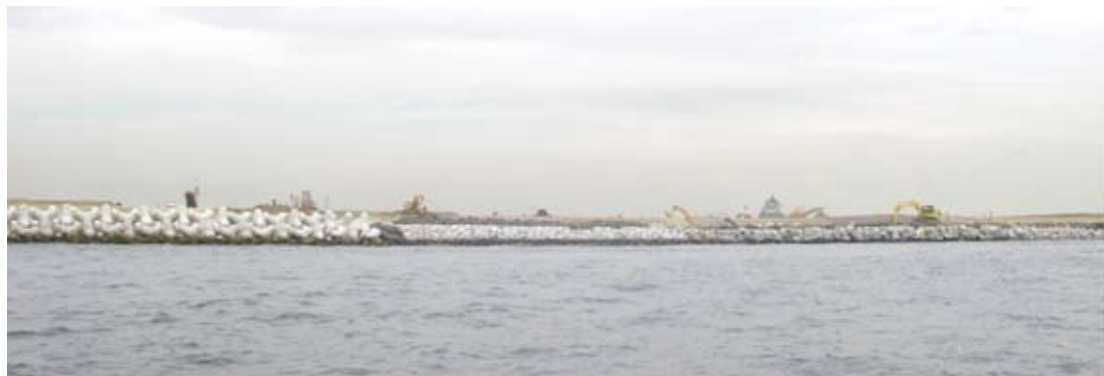
写真一3 沖側開口部締切り状況(延長約300m)
