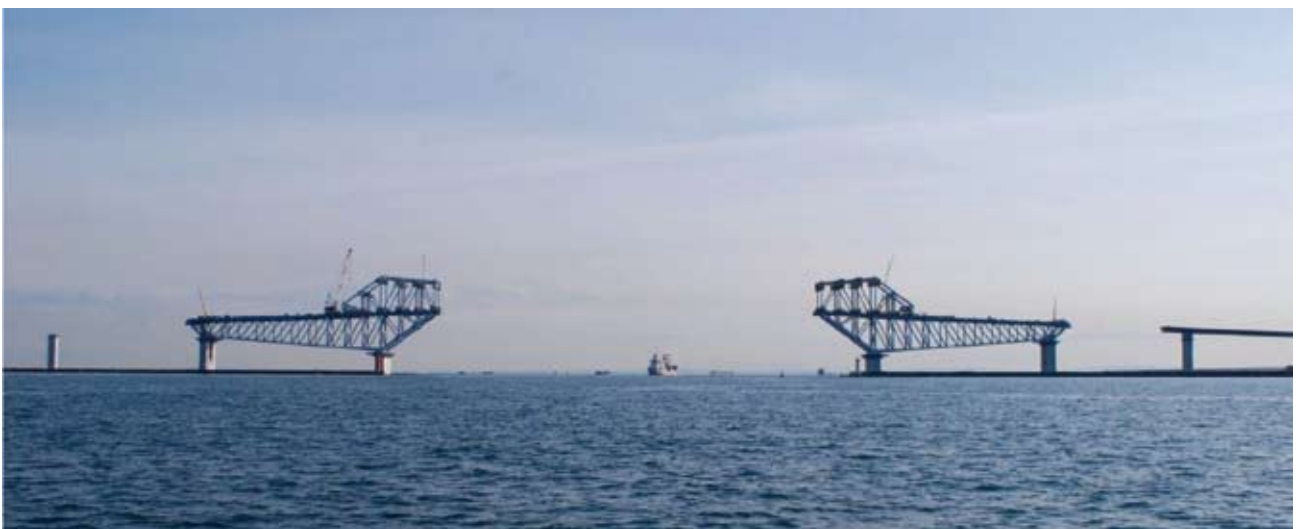
写真-2 上部トラス架設終了(H21.12月上旬)
