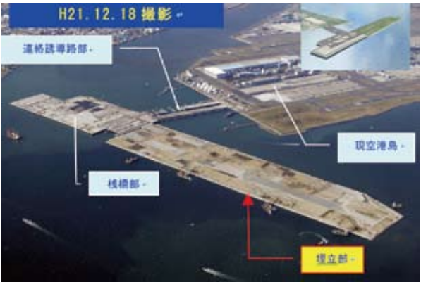
写真-1 D滑走路全体・埋立部位置
