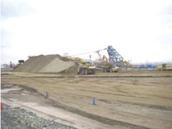
写真一10 堤外揚土施工状況
