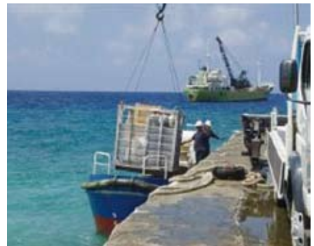
港湾施設が整備されていないことにより小型船に積み替えて資機材を陸揚げ(南鳥島)
