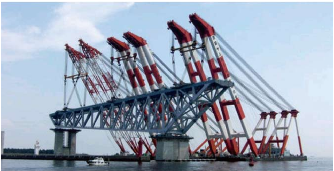
架設状況写真
