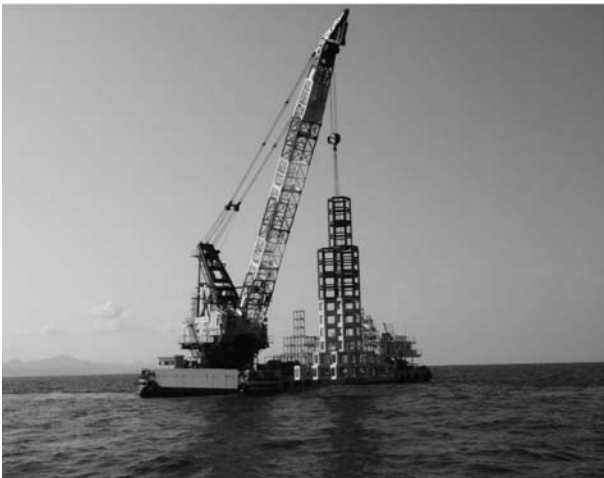
島根地区広域漁場整備事業 組立魚礁据付状況 ハニカム魚礁(11.1×12.0×21.0 重量:71.84t)
