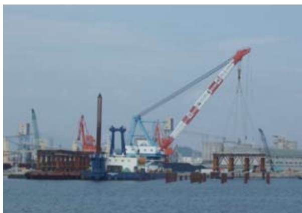
写真-2 ジャケット据付状況
