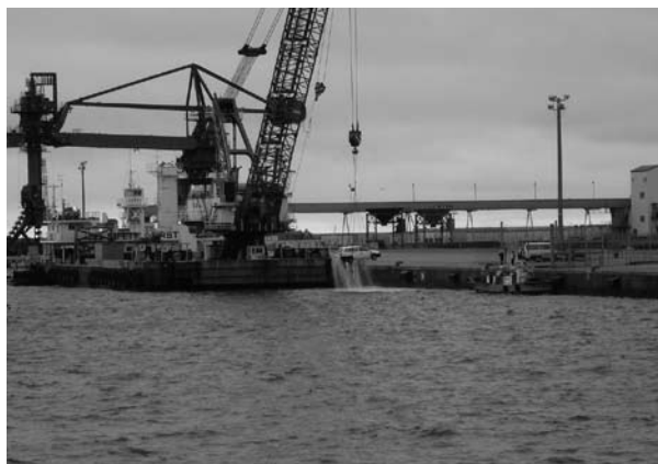
津波防災訓練 起重機船による障害物引き上げ
