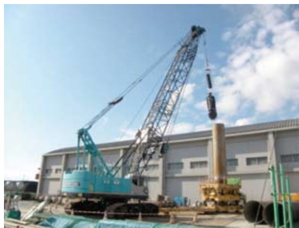
写真-3 陸上部下部工事(場所打ち杭)状況
