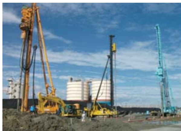
写真-4 陸上部地盤改良工事状況
