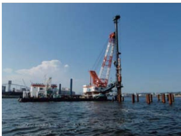
写真-1 鋼管杭打設状況
