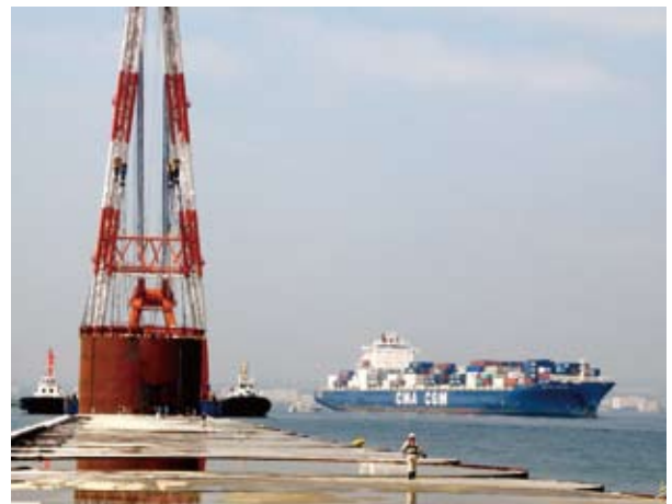
写真-5 鋼板セル据付
