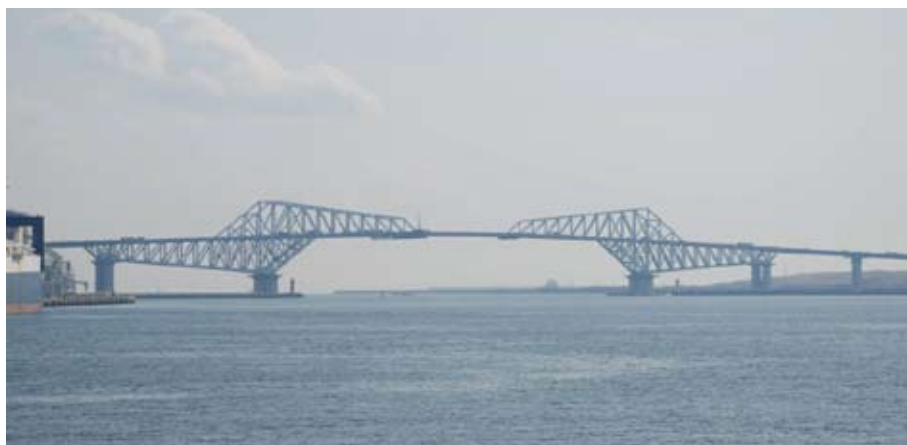
写真-3 東京ゲートブリッジの現況(2011年3月)
