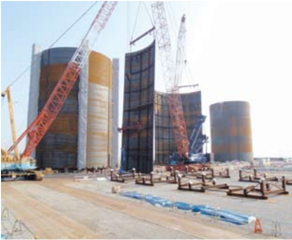
写真-3 鋼板セルの大組
