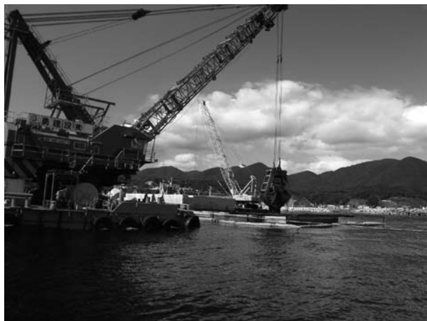
久遠漁港島防波堤建設工事
