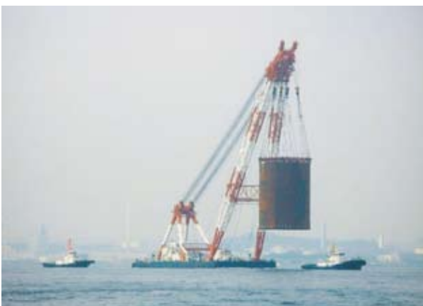
写真-4 鋼板セルの曳航
