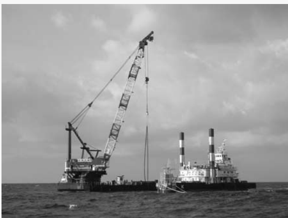
御前崎沖GPS波浪計設置工事
