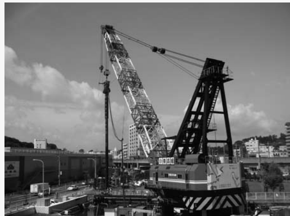
塩釜港胸壁工事
