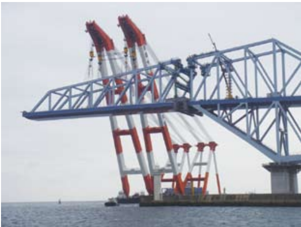
写真-1 中央径間トラス桁の架設状況(中央防波堤側)
