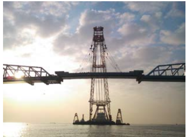
写真-2 中央径間箱桁の架設状況
