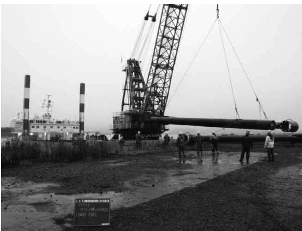
室蘭港岸壁改良工事
