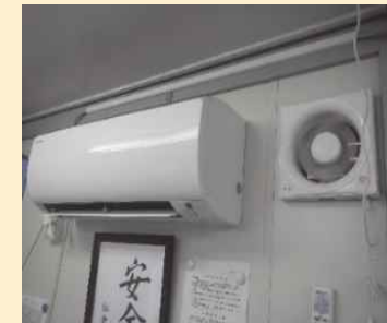
扇風機や換気扇とエアコンを併用
